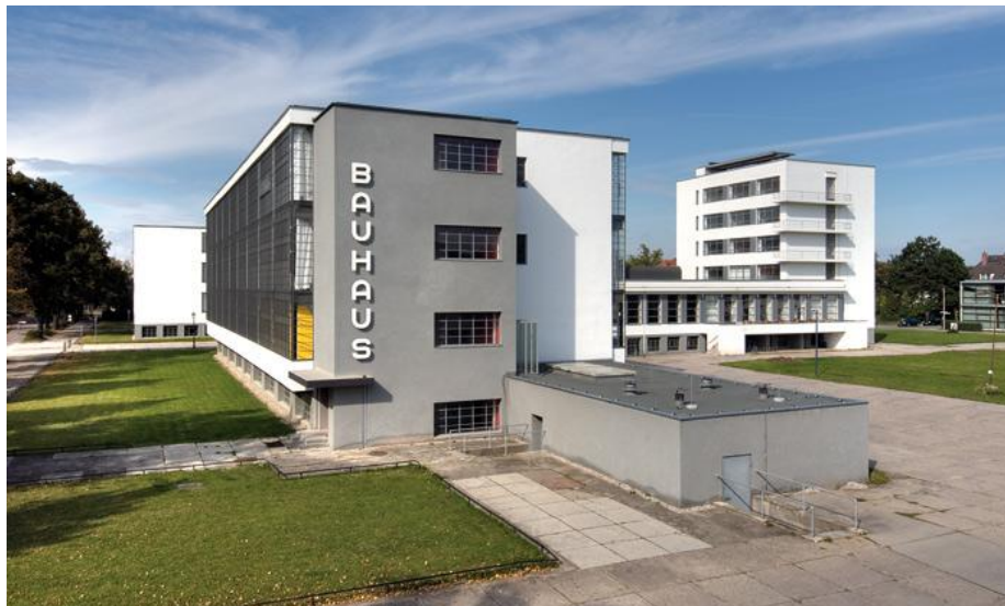
Obrázek 31: Budova Bauhausu v Dessau
