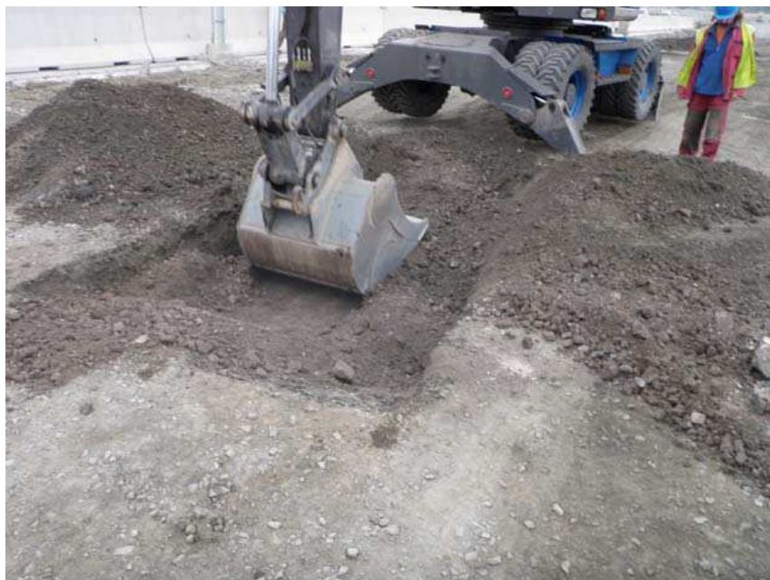
Obr. 6.5: Dálnice D4708 – odtěžování konstrukčních vrstev a svrchní části aktivní zóny, které byly postiženy objemovými změnami [24]
