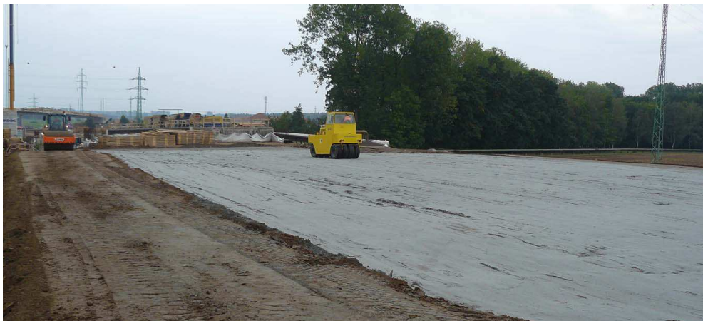
Obr. 4.2: Stavba MÚK Opatovice [18]
