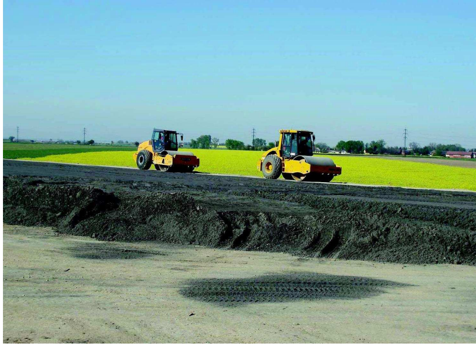
Obr. 4.1: Stavba dálnice D11 [18]
