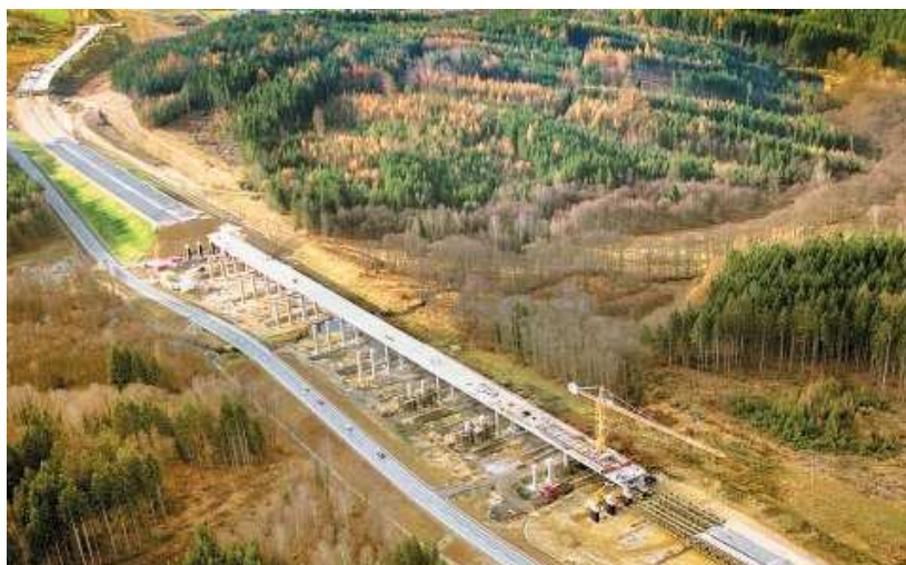
Obr. 2.7: Letecký snímek výstavby komunikace R6 [19]
