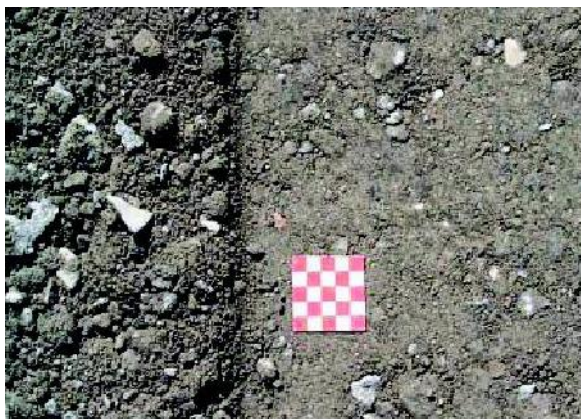
Obr. 6.3: Zhutnění technologické vrstvy struskového kameniva z vysokopecní strusky po prvním pojezdu [23]
