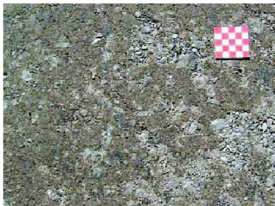
Obr. 6.4: Zhutnění na požadovanou hodnotu míry zhutnění [23]
