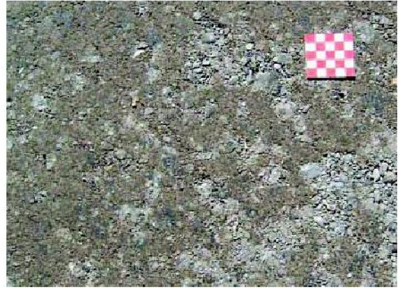
Obr. 6.4: Zhutnění na požadovanou hodnotu míry zhutnění [23]
