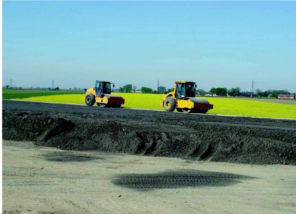
Obr. 4.1: Stavba dálnice D11 [18]
