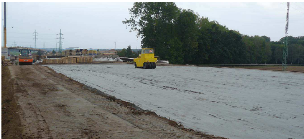
Obr. 4.2: Stavba MÚK Opatovice [18]
