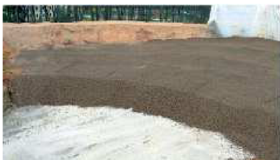
Obr. 2.8: Nasypávání lehčeného tělesa, dole popílek, na něm vrstva Liaporu [19]
