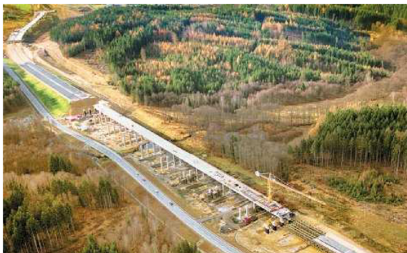
Obr. 2.7: Letecký snímek výstavby komunikace R6 [19]
