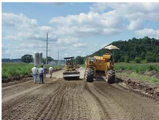
Obr. 2.4: Mísení zeminy s popínkem [21]
