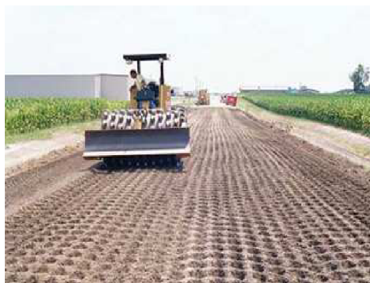
Obr. 2.5: Hutnění stabilizované zeminy [21]
