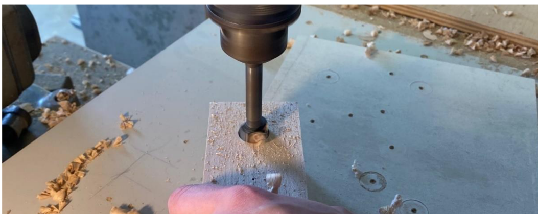
Obrázek 76 - Vyvrtání otvorů pro kolíky k výškovému nastavení židle
