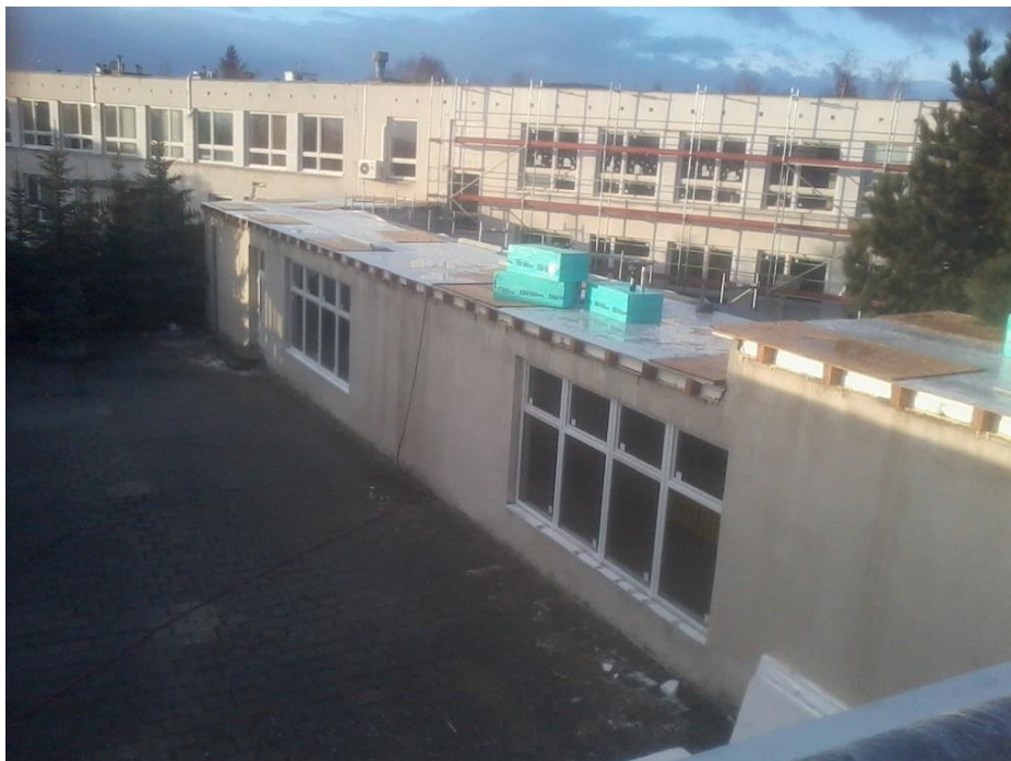
Obrázek 8 – Stavební práce na 4. ZŠ Jirkov
