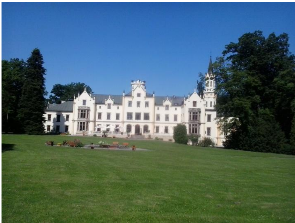
Obr. 17: Zámek Vráž s bazénkem, pohled zezadu
