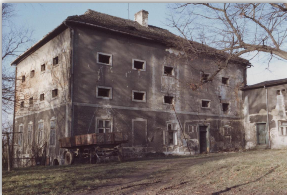
Pohled na barokní sýpku okolo roku 1960 těsně před zbouráním, zdroj: obecní úřad Dolní Lutyně
