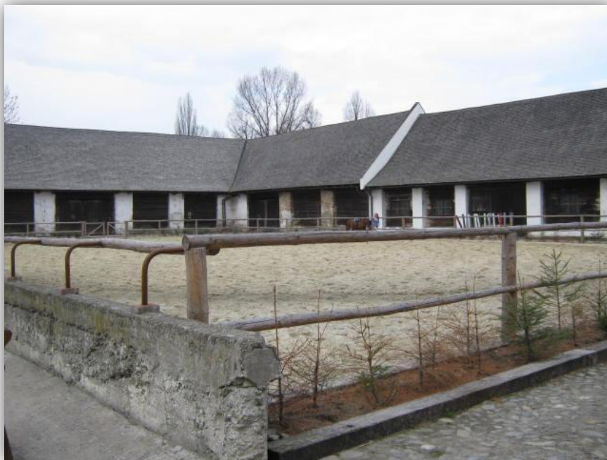
Pohled na hospodářské budovy ve tvaru písmene „L“, zdroj: Foto Kateřina Rončková, duben 2012
