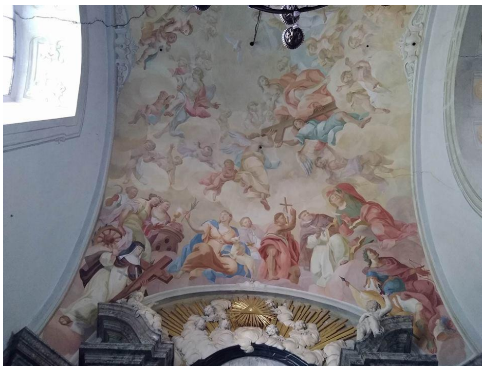
25. Část stropu v kapli sv. Kosmy a Damiána.
