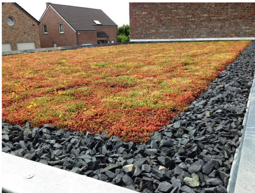
Obr. 9 – Extenzivní zelená střecha (KNAUF INSULATION, 2017)
