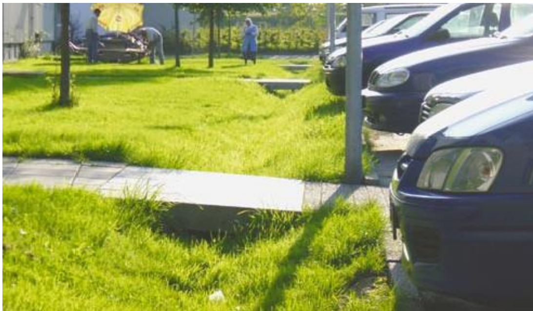
Obr. 5 – Vsakovací průleh ( www.tzb-info.cz )
