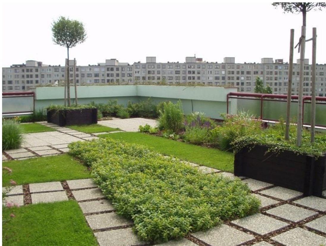
Obr. 10 – Intenzivní zelená střecha (ACRE, 2017)
