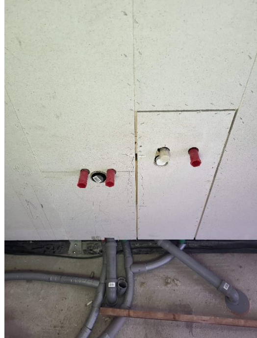
Obrázek 58 - Utěsnění vývodu odpadního potrubí (Brich, 2024).
