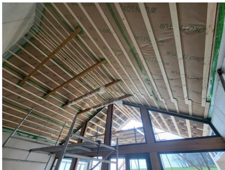
Obrázek 72 - Utěsnění místa styku pohledové kleštiny krovu s hlavní vzduchotěsnicí vrstvou (Brich, 2024).
