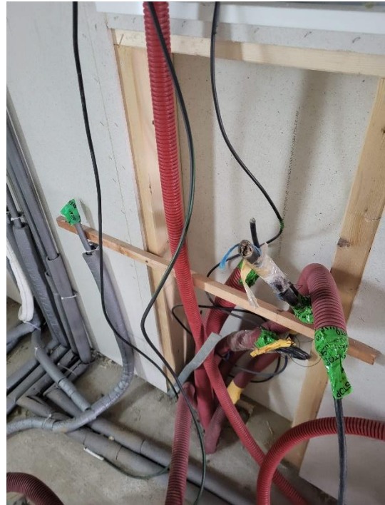
Obrázek 62 - Utěsnění průduchu kabelu skrze kabelovou chráničku (Brich, 2024).
