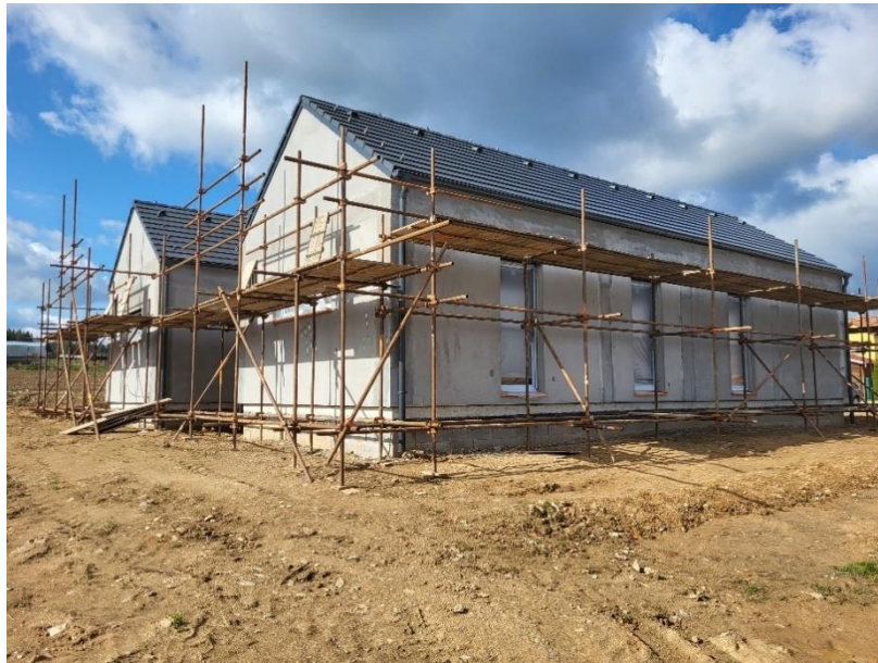
Obrázek 55 - RD Příbram ve fázi rozestavěnosti při provádění Blower-door testu (Brich, 2024).
