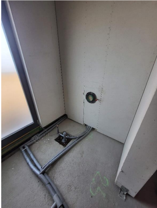
Obrázek 66 - Utěsnění vývodu odpadního potrubí (Brich, 2024).
