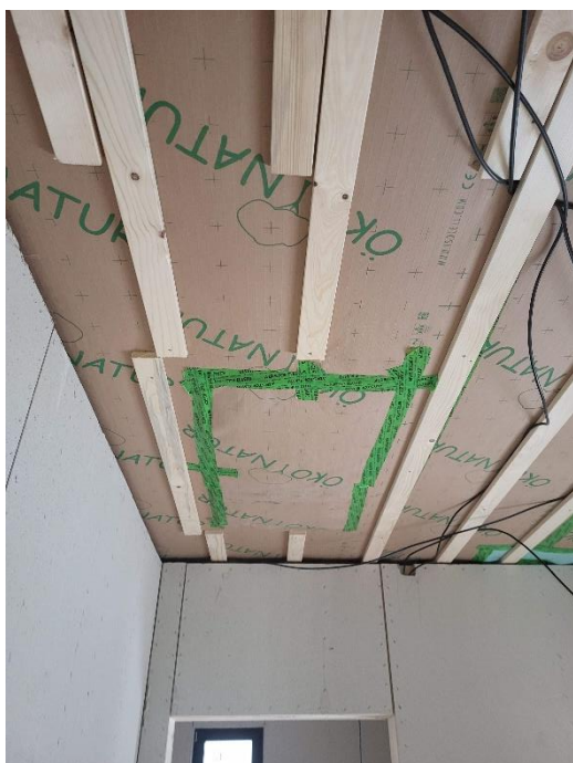
Obrázek 68 - Utěsnění vstupu do půdního prostoru (Brich, 2024).
