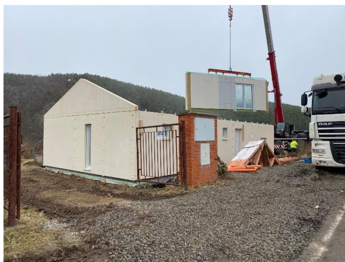
Obrázek 3 - celostěnový panel (autor práce, 2023).
