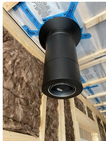
Obrázek 46 - utěsnění komínu pomocí těsnícího balónku (autor práce, 2024).
