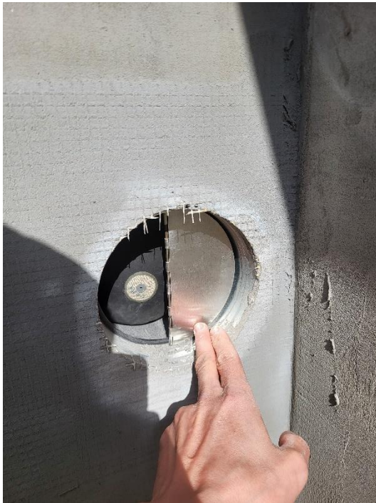
Obrázek 61 - Utěsnění vývodu výdechového/nasávacího potrubí VZT. (Brich, 2024).
