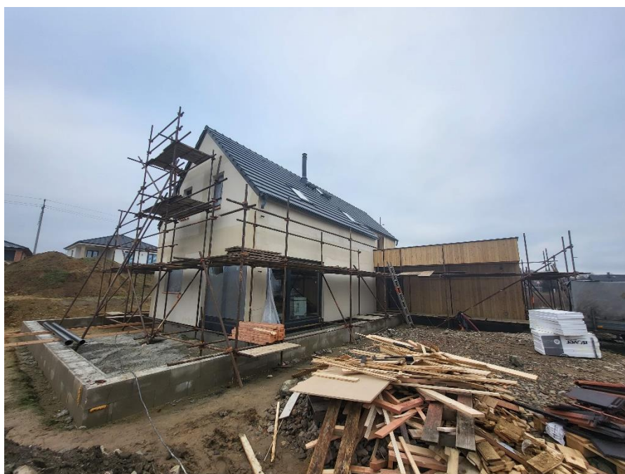
Obrázek 64 – RD Mělnická Vrutice ve fázi rozestavěnosti při provádění Blower-door testu (Brich, 2024).
