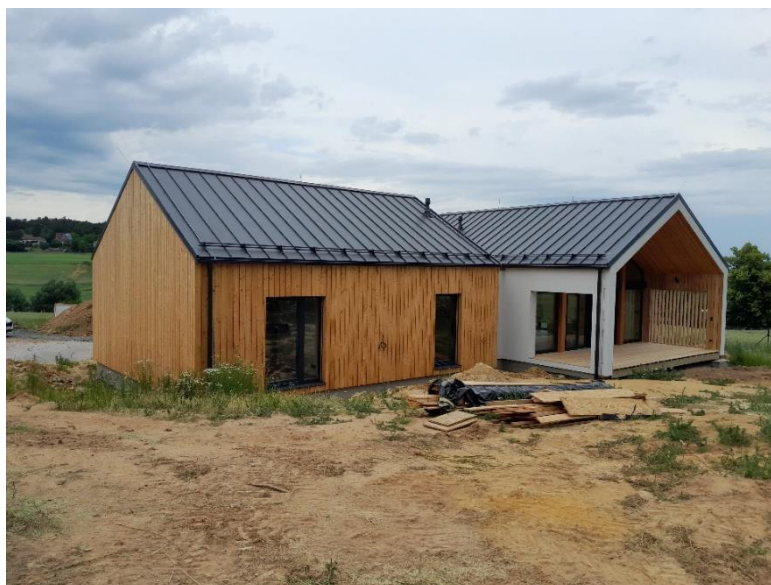
Obrázek 49 - RD Zichovec ve fázi předávky investorovi (autor práce, 2024).
