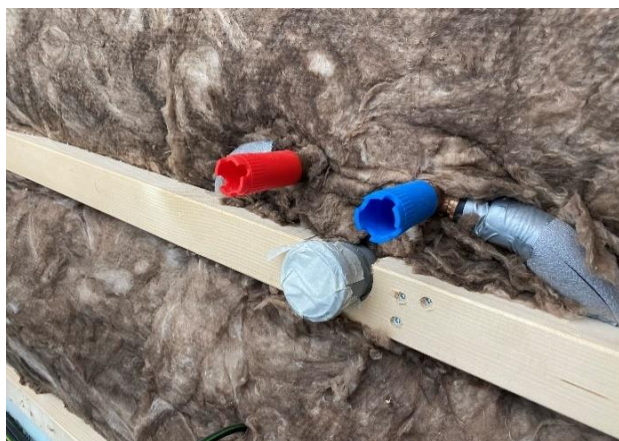
Obrázek 45 - utěsnění odpadu papírovou páskou (autor práce, 2024).
