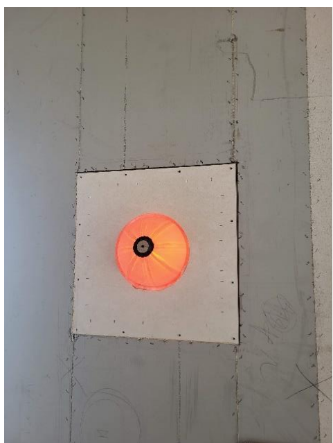
Obrázek 52 - Utěsnění prostupu komínového tělesa (Brich, 2024).
