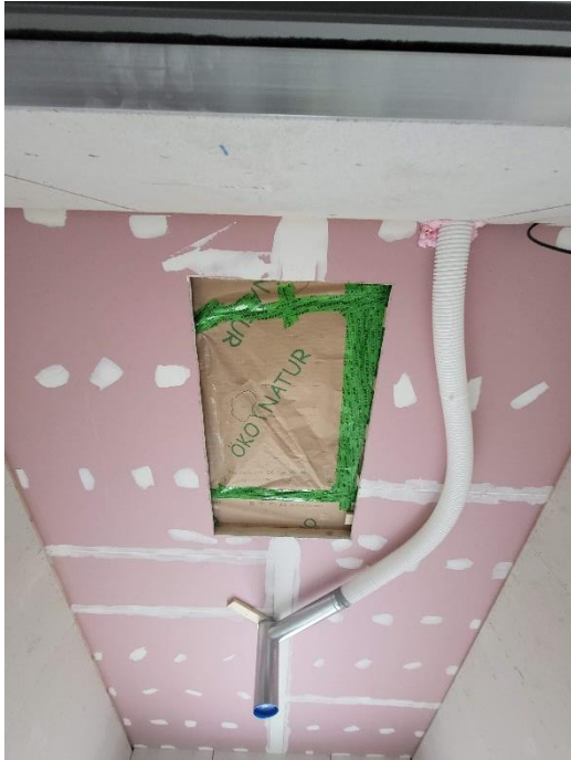
Obrázek 57 - Utěsnění vstupu do půdního prostoru (Brich, 2024).
