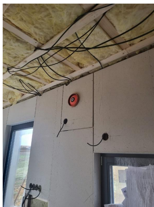
Obrázek 69 - Utěsnění průduchu pro digestoř (Brich, 2024).
