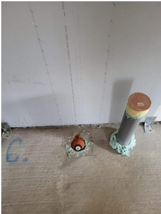
Obrázek 59 - Utěsnění externího přívodu vzduchu pro krbová kamna (Brich, 2024).
