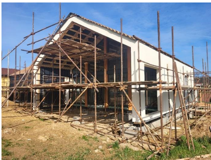
Obrázek 48 - RD Zichovec ve fázi rozestavěnosti při provádění Blower-door testu (Brich, 2024).
