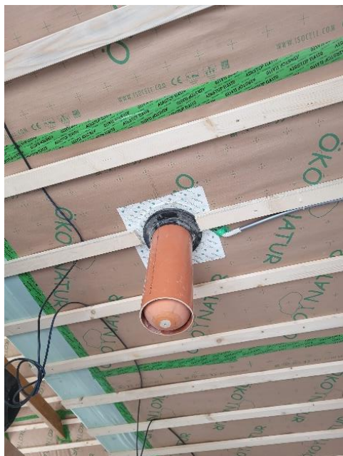
Obrázek 50 - Utěsnění potrubí lokálního odvětrání (Brich, 2024).
