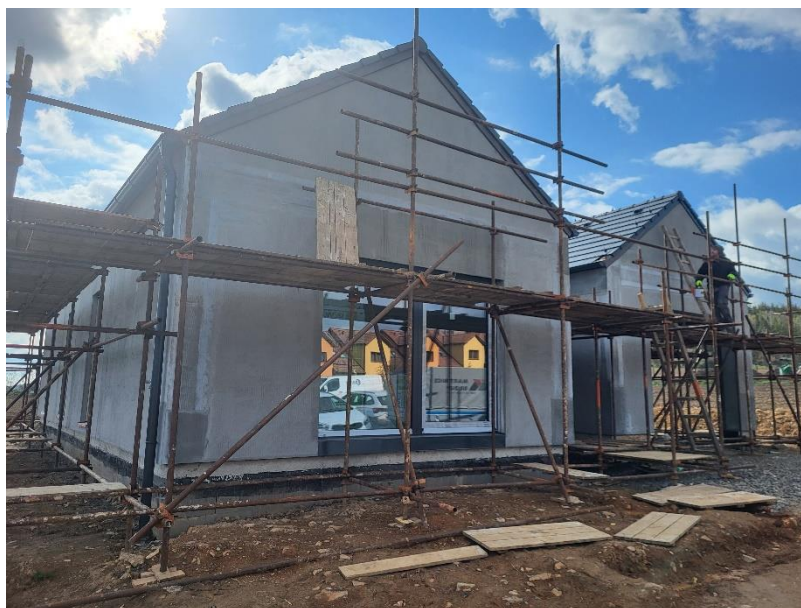
Obrázek 54 - RD Příbram ve fázi rozestavěnosti při provádění Blower-door testu (Brich, 2024).
