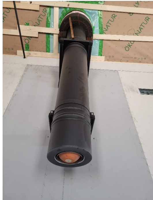
Obrázek 60 - Utěsnění průduchu komínového tělesa (Brich, 2024).
