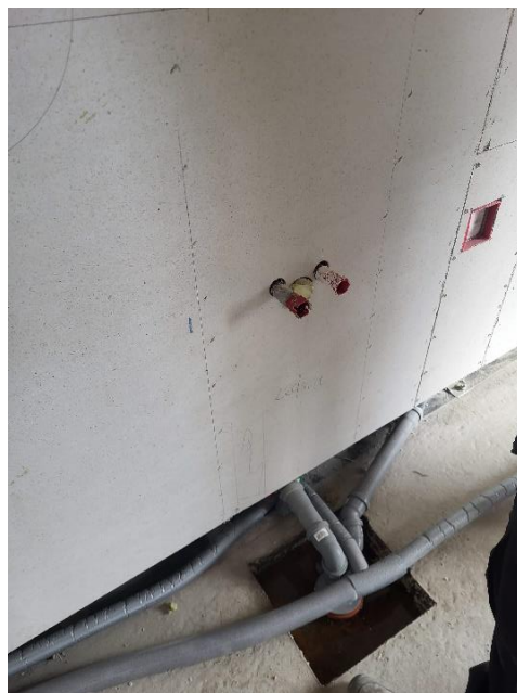
Obrázek 53 - Utěsnění vývodu odpadního potrubí (Brich, 2024).
