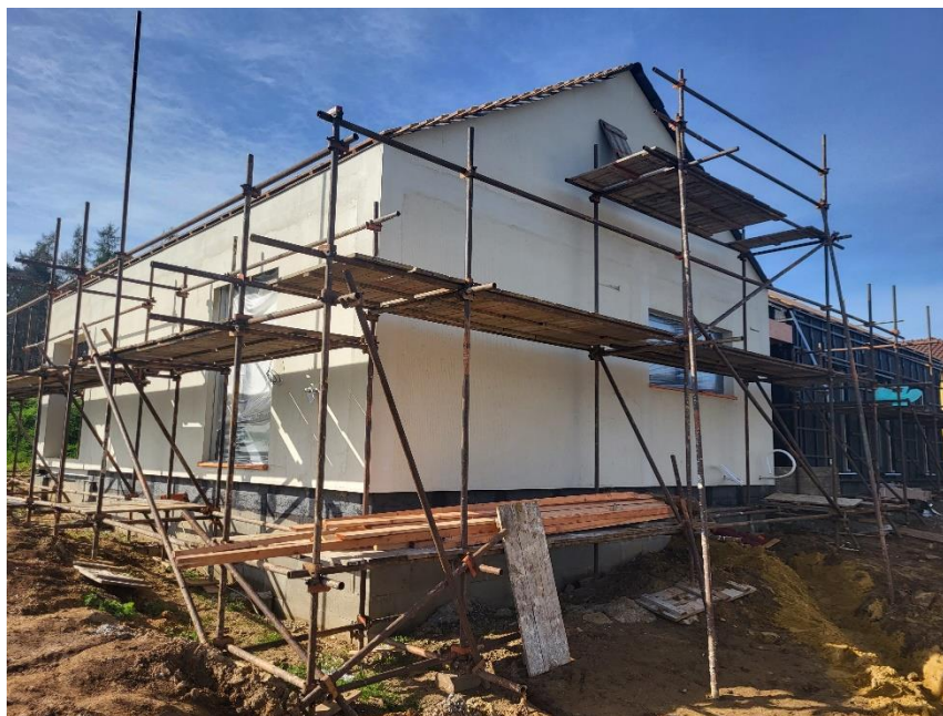
Obrázek 47 - RD Zichovec ve fázi rozestavěnosti při provádění Blower-door testu (Brich, 2024).
