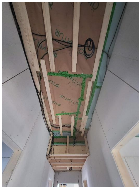
Obrázek 51 - Utěsnění vstupu do půdního prostoru (Brich, 2024).
