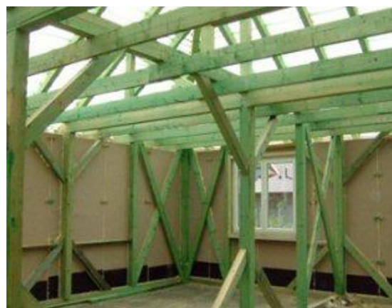
Obrázek č. 3: Dům opláštěný slaměnými deskami
