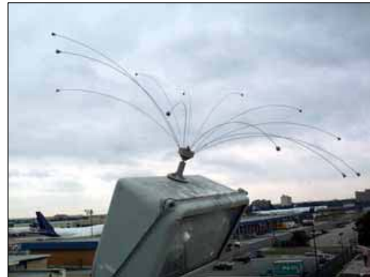
P4-12: Kovové hroty na znacích (vlevo) případně „ježek“ na světlech zabrání usednutí ptáků
