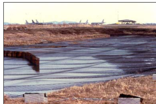
P5-4: Síť zabraňující ptákům jak v pití vody tak usednutí na ni
