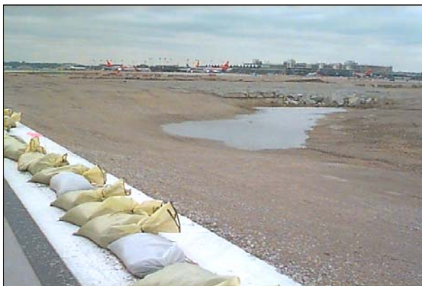
P4-7: Vodní plochy v prostoru letiště představují výrazný atraktant, který je nutné odstranit a nebo k němu alespoň znemožnit přístup (drenáže, sítě, míčky)
