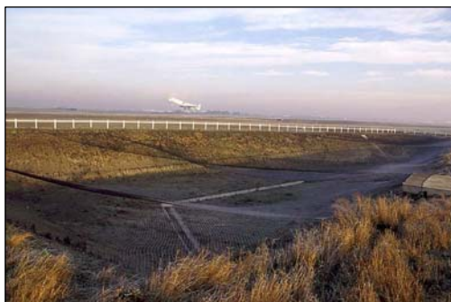
P5-4: Síť zabraňující ptákům jak v pití vody tak usednutí na ni
