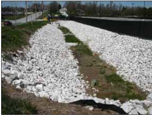
P5-5: Příklady odvodňovacího systému v podobě kanálů
