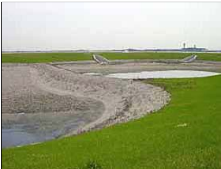
P5-6: Sběrná nádrž navržená (pro případy silného deště) schopná odvést veškerou vodu do 48 hodin
