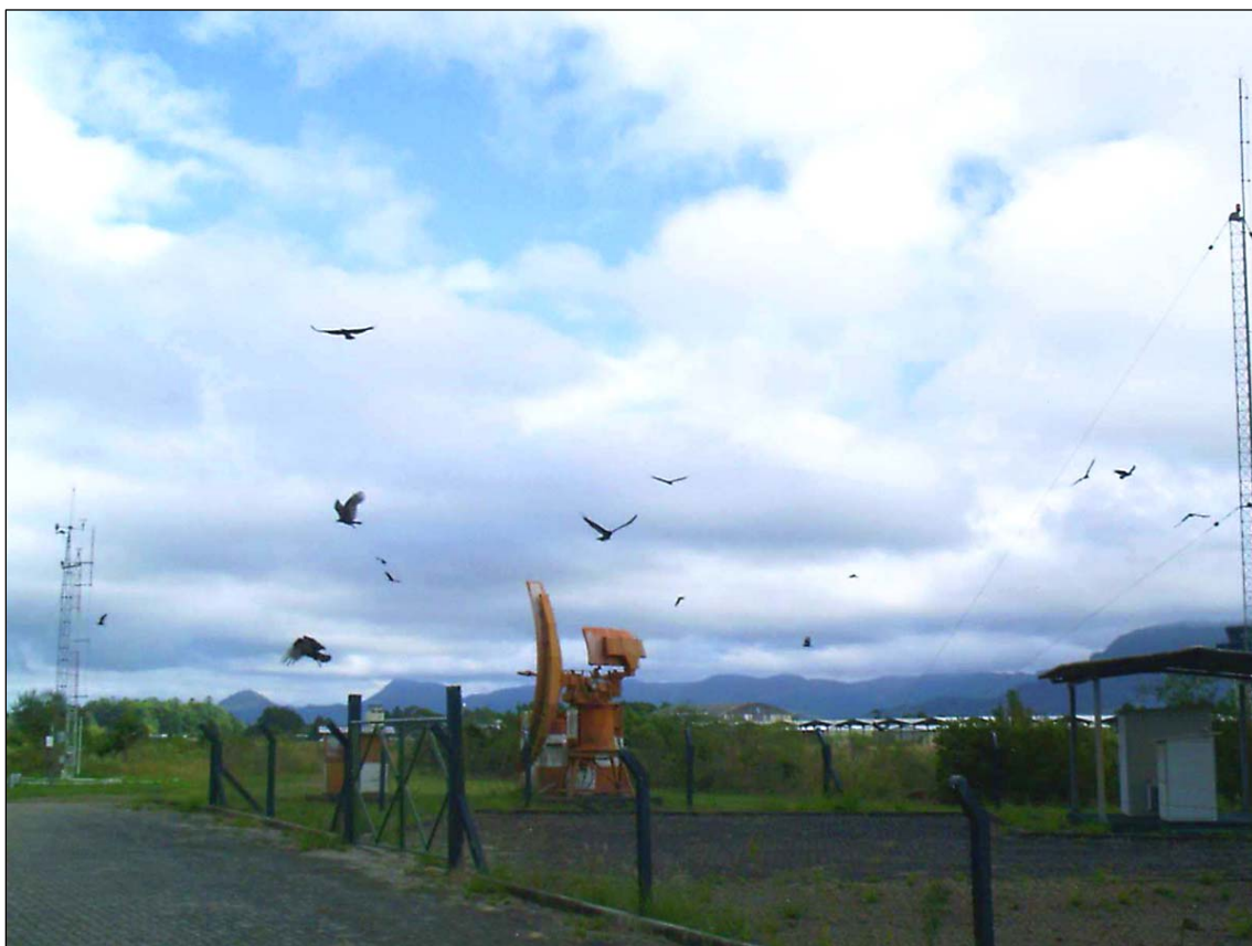
P4-16: Ptákům by měl být zamezen přístup k radarovým a dalším konstrukcím
