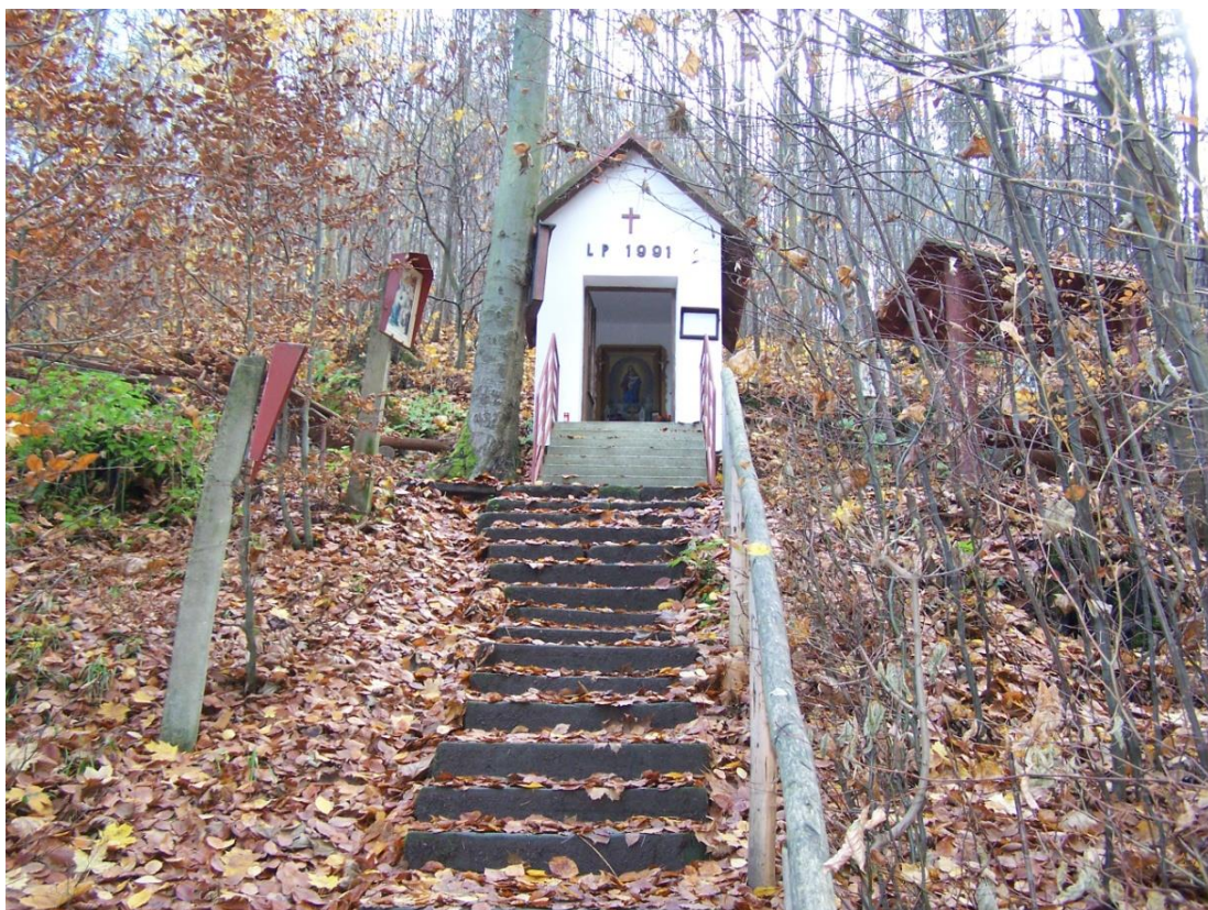
Obr. 71: Hůra u Petrovic, kaplička Panny Marie, vstupní průčelí
