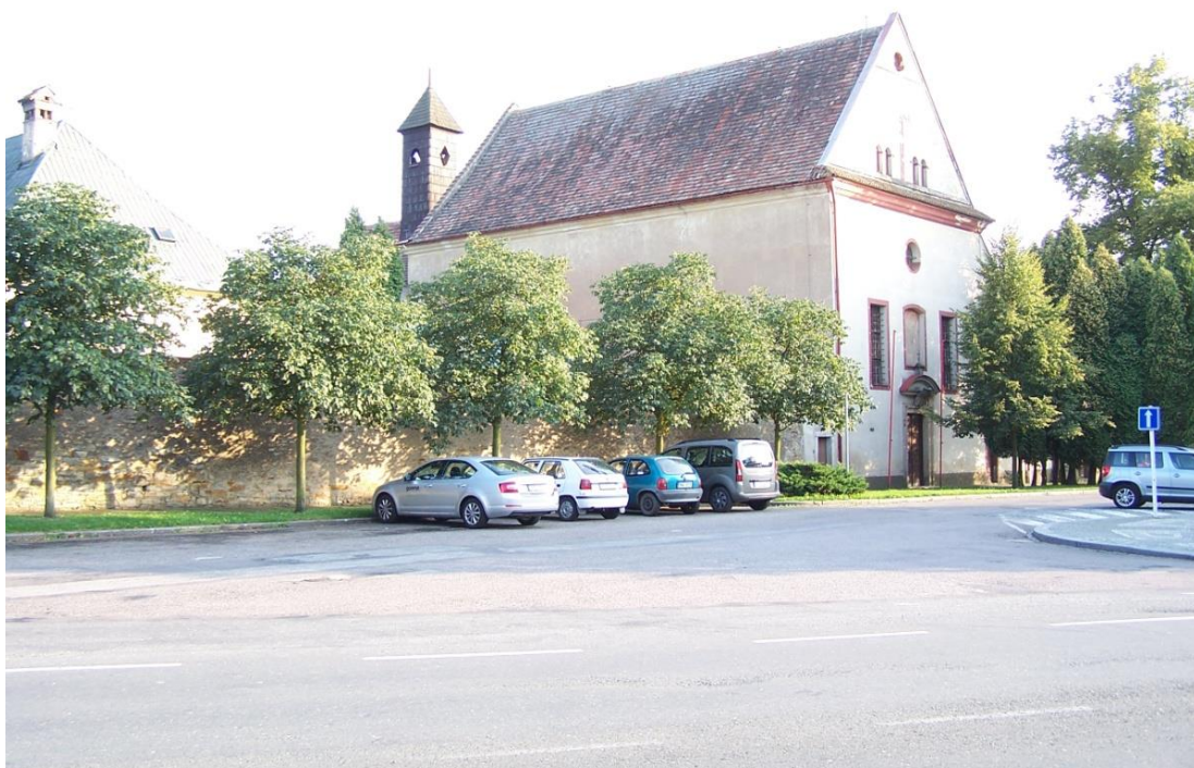
Obr. 41: Opočno, pohled od severovýchodu
