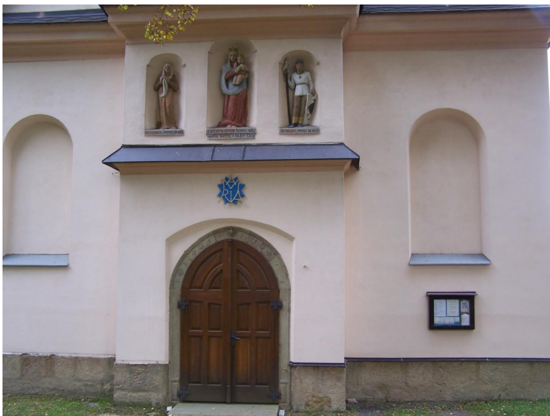
Obr. 65: Horní Čermná, vstupní průčelí do kostela
