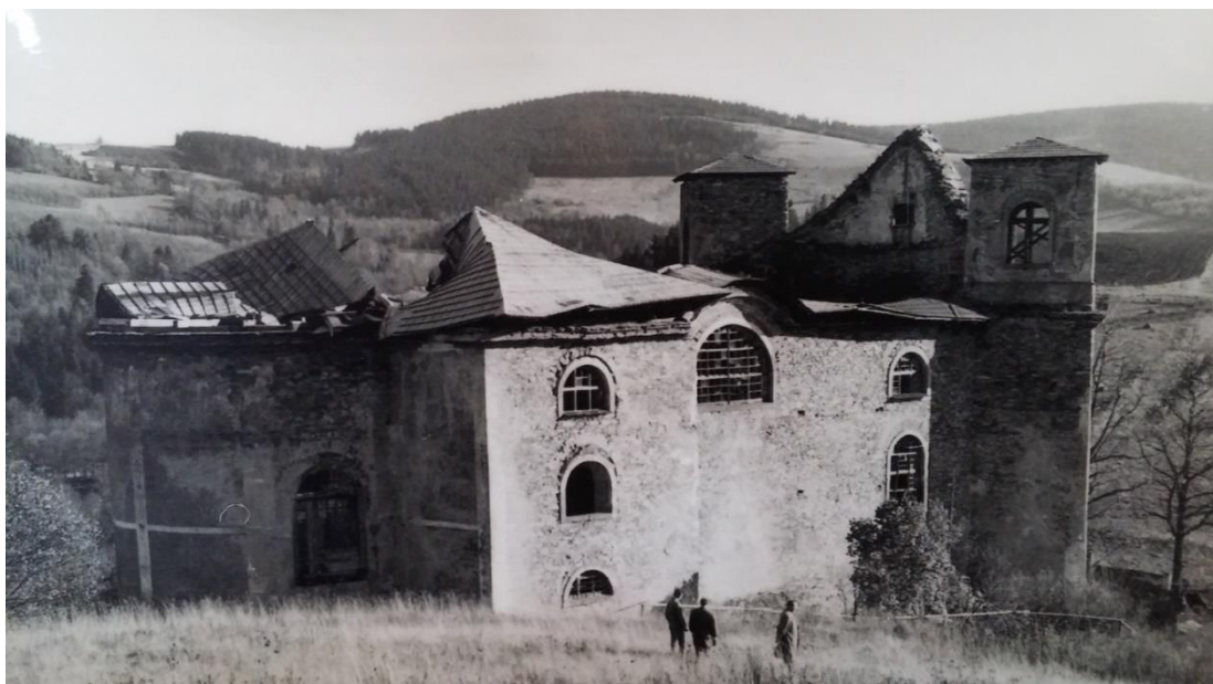
Obr. 34: Neratov, stav kostela v roce 1957 (foto – archiv FÚ Neratov)
