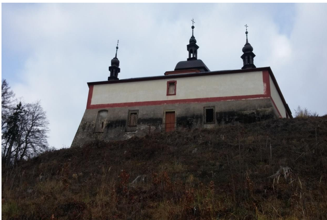
Obr. 82: Letohrad, poutní areál, pohled od jihu
