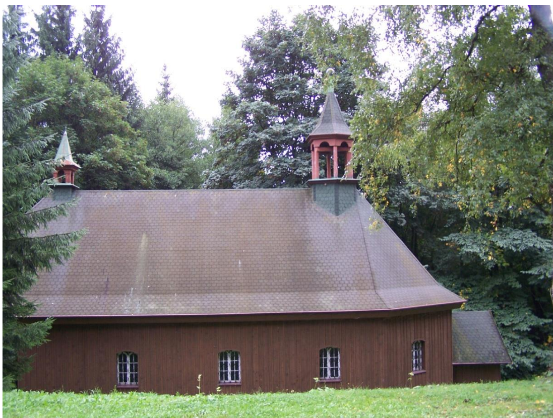
Obr. 4: Dříš, boční pohled od jihu
