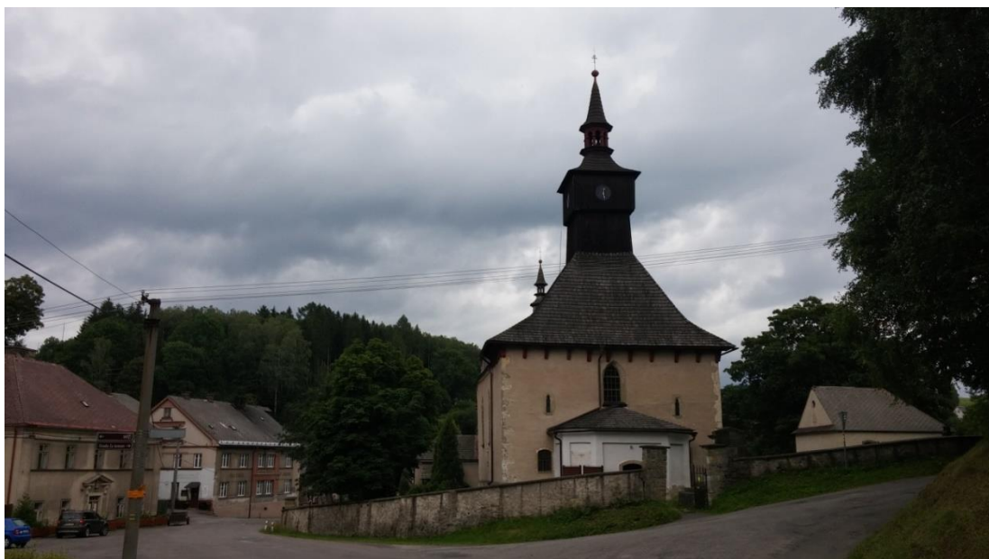
Obr. 75: Klášterec nad Orlicí, kostel Nejsvětější Trojice, pohled od západu
