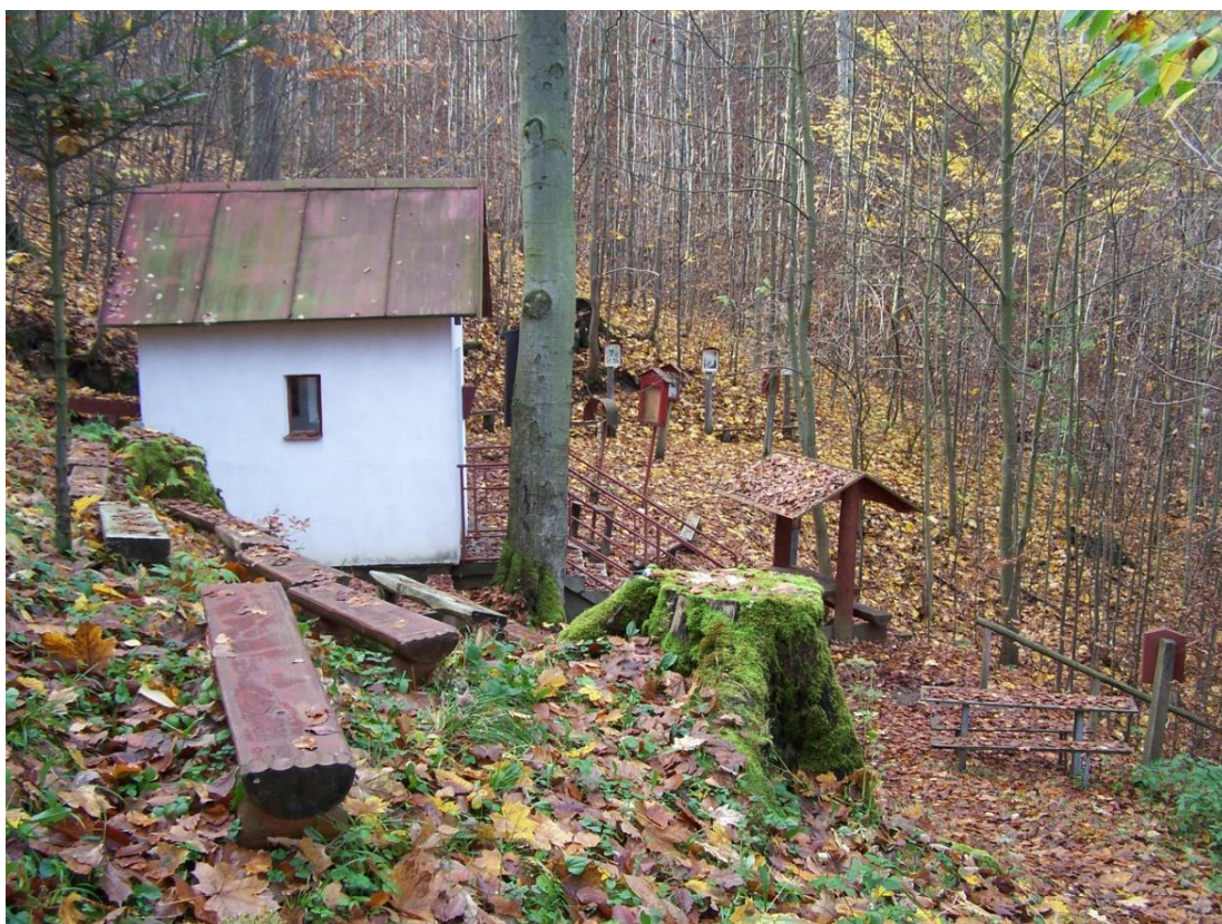
Obr. 74: Hůra u Petrovic, křížová cesta a boční pohled na kapličku
