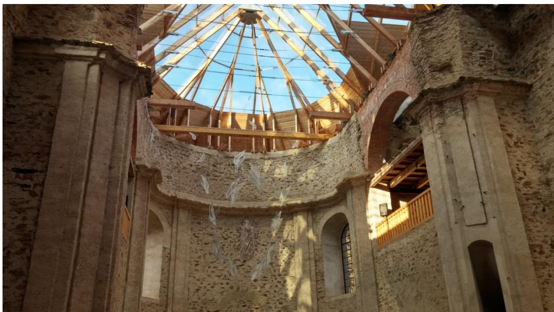
Obr. 38: Střecha kostela po rekonstrukci, nad presbytářem
