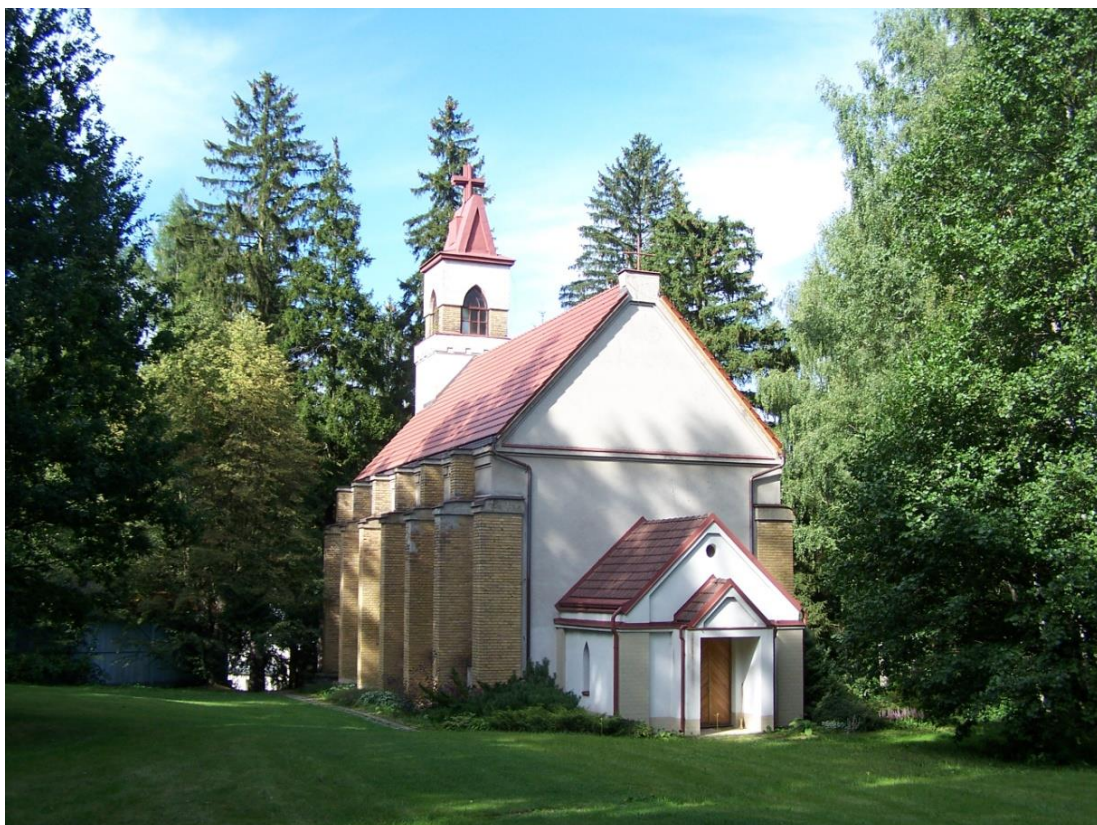
Obr. 46: Rokole, poutní kostel, pohled na sakristii
