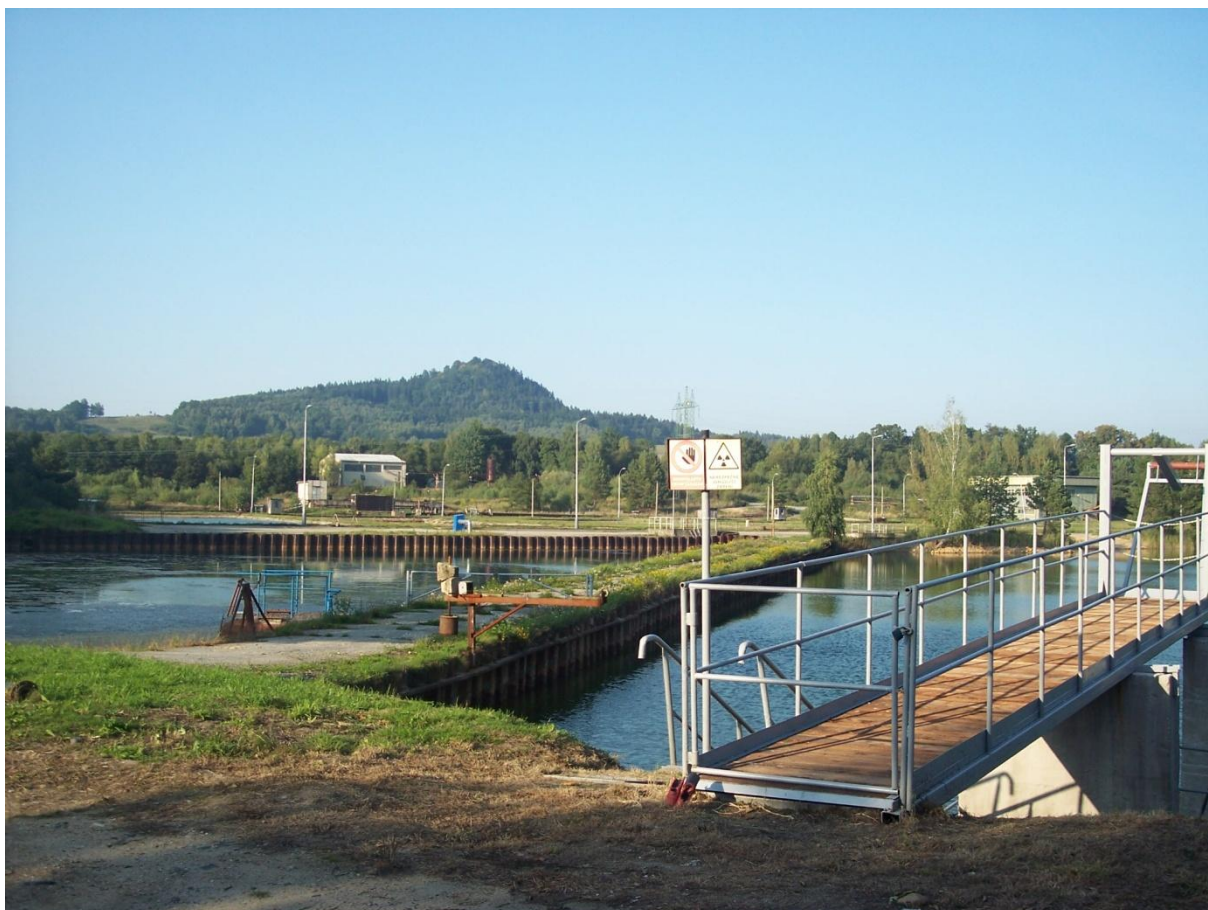
Obr. 37 Areál dolu Hamr I. Foto: vlastní
