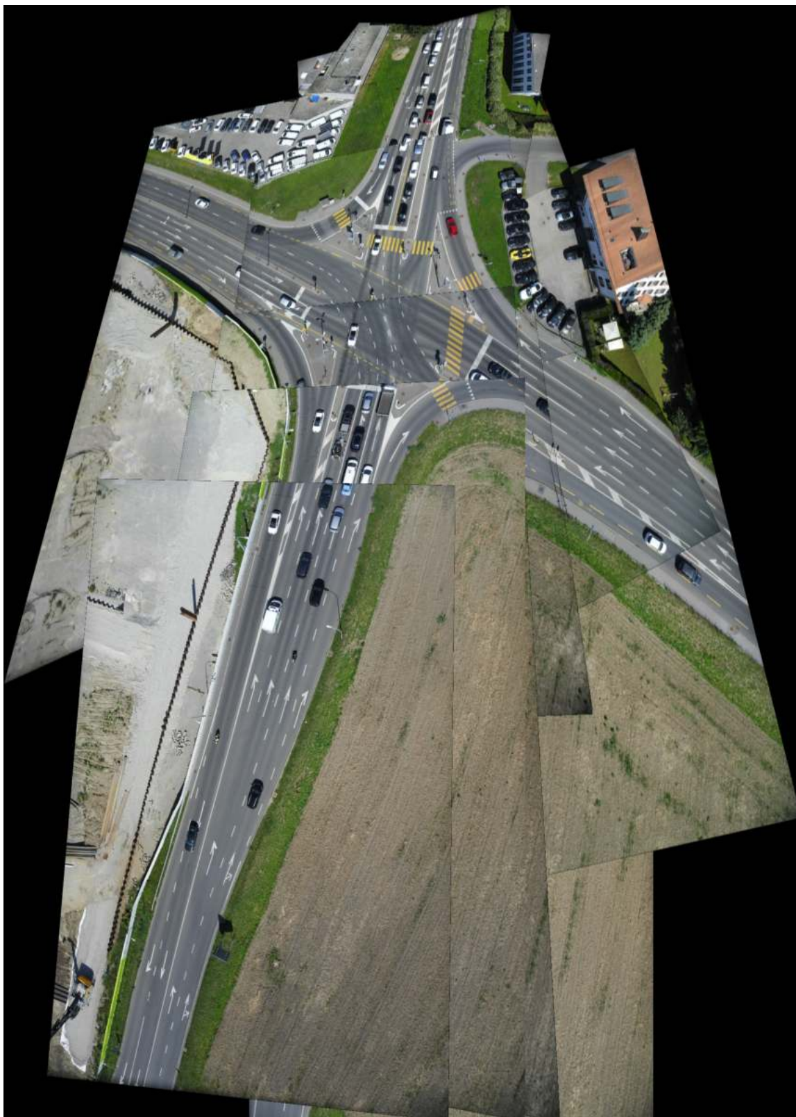
Obrázek A.6: oblast staveniště
