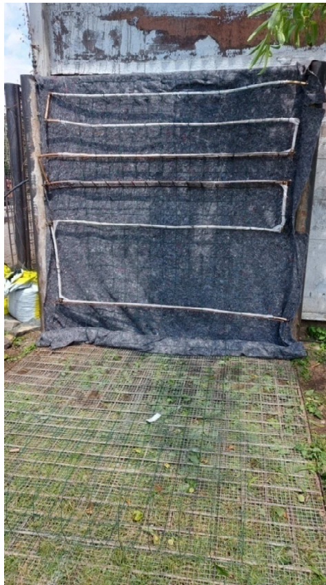
Obr.2 Modul stěny zevnitř, Kateřina Špatenková 2021
