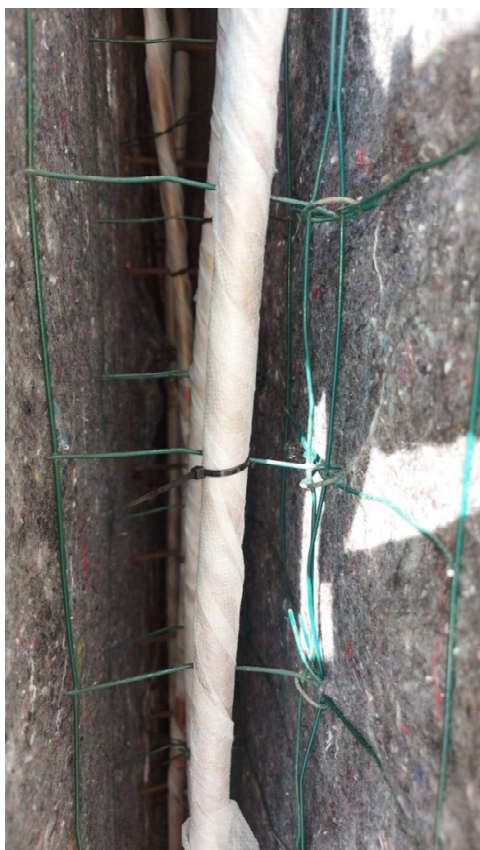
Příloha č. 27, Detail přichycení kapkovací závlahy, autor Kateřina Špatenková, 2021
