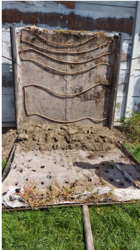
Obr. 1 Původní stav stěny, Kateřina Špatenková 2021
