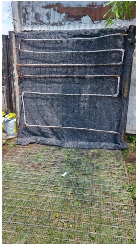
Obr.2 Modul stěny zevnitř, Kateřina Špatenková 2021
