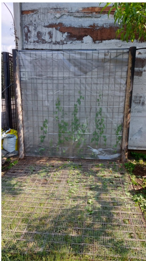
Příloha č. 25, Umístění polyethylenové folie na stěně č. 1, autor Kateřina Špatenková, 2021
