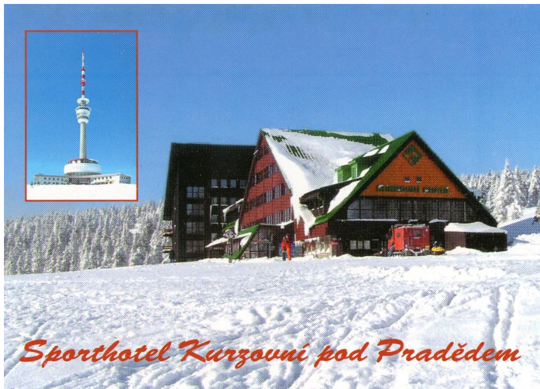
Obr. 11: Chata Kurzovní po přestavbě na Sporthotel Kurzovní Zdroj: Archiv T. Petruně
