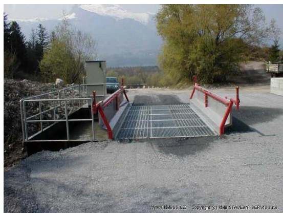
Obr. 4.10. a 4.11. Očistná rampa bude umiestnená na výjazde zo staveniska
