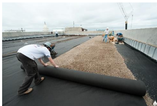
Obr. č. 24 - Instalace protikořenové vrstvy ( https://www.aoc.gov/blog/pictures-green-roof-comes-alive )
