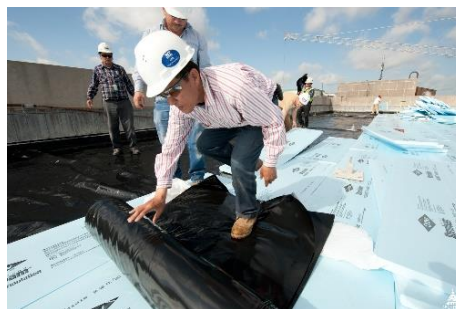
Obr. č. 26 - Instalace hydroakumulační vrstvy ( https://www.aoc.gov/blog/pictures-green-roof-comes-alive )
