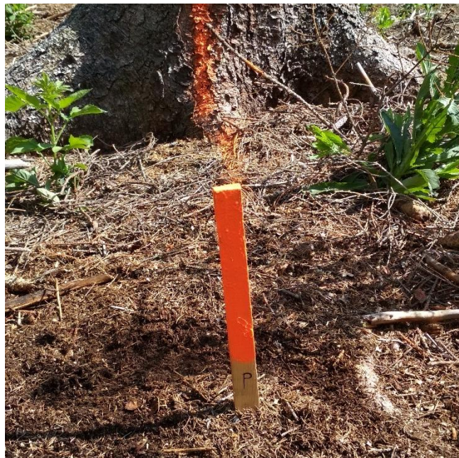
Obr. 17: Stabilizace počátečního bodu polygonového pořadu
