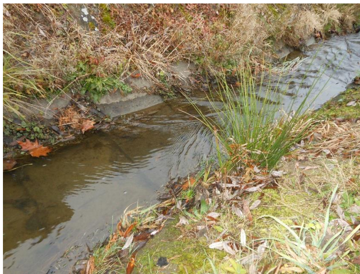
Obr. č. 45: Ukázka opevněného koryta v obci Čím. Obrazová fotodokumentace byla pořízena v místě středně ovlivněné části toku (foto vlastní)
