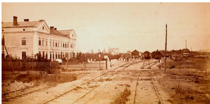
Obr. 9: Původní stanice a kolejiště na KBD v Bohumíně (zdroj: zmms.cz, 2016)
