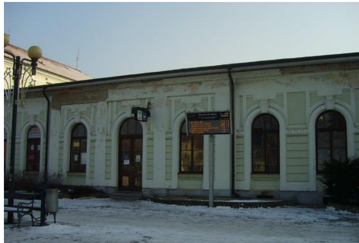
Obr. č. 20: Informační tabule ODIS před budovou nádraží (Skokan, 1/2017)
