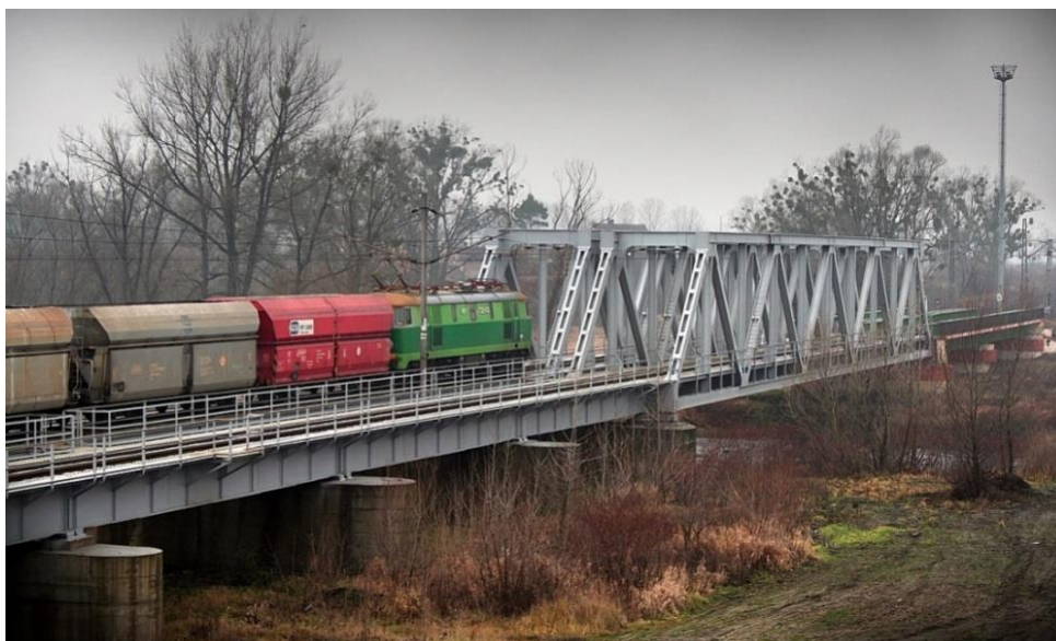
Obr. 12: Současná podoba železničního mostu (zdroj: www.meandryodry.wz.cz , 2015)
