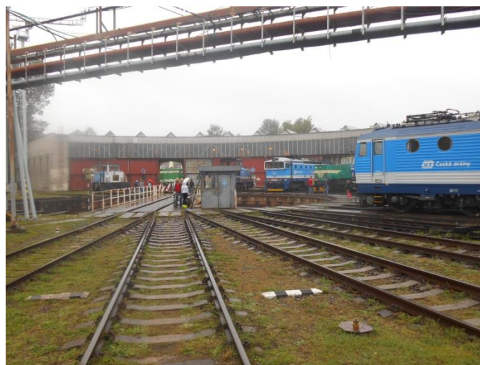
Obr. č. 15: Točna a budova rotundy v areálu depa Bohumín (Skokan, 9/2015)
