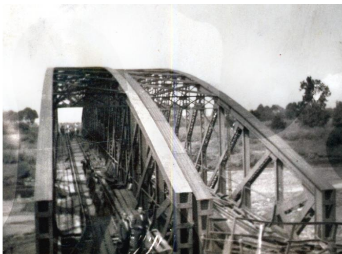
Obr. 11: Železniční most přes řeku Odru (zdroj: www.meandryodry.wz.cz, 2015)
