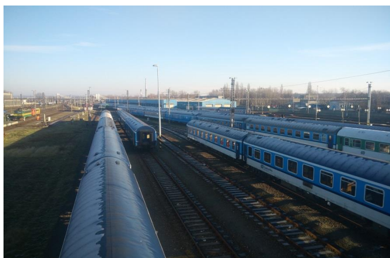
Obr č. 8: Areál THÚ (Technicko-hygienické údržby) tvoří čtyři části hala THÚ, myčka, fekální kolej a čistička odpadních vod (Skokan, 12/2016)
