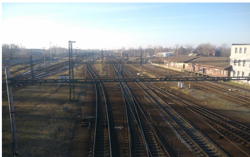
Obr č. 7: Železniční trať ve směru Ostrava a Chalupki (Skokan, 12/2016)
