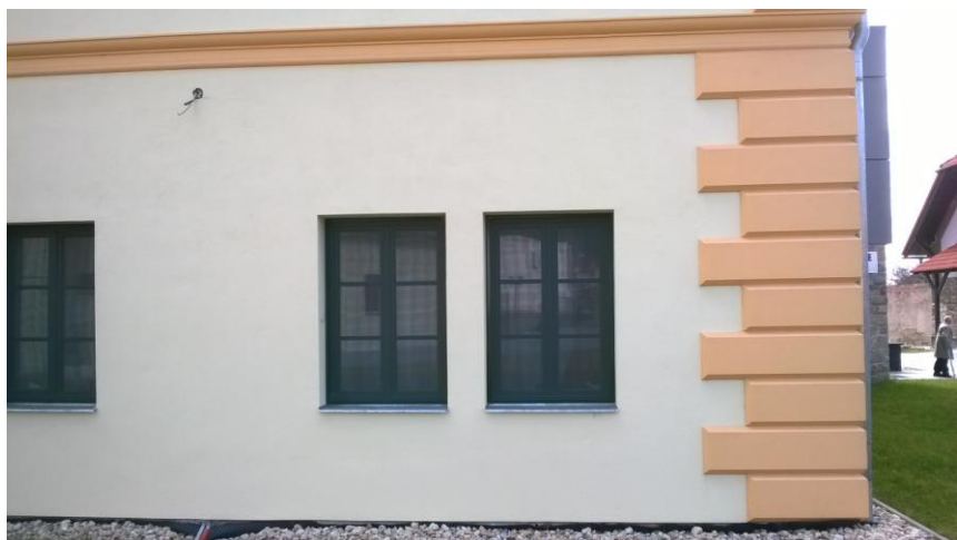
Obrázek 16 Pohled na severní roh objektu
