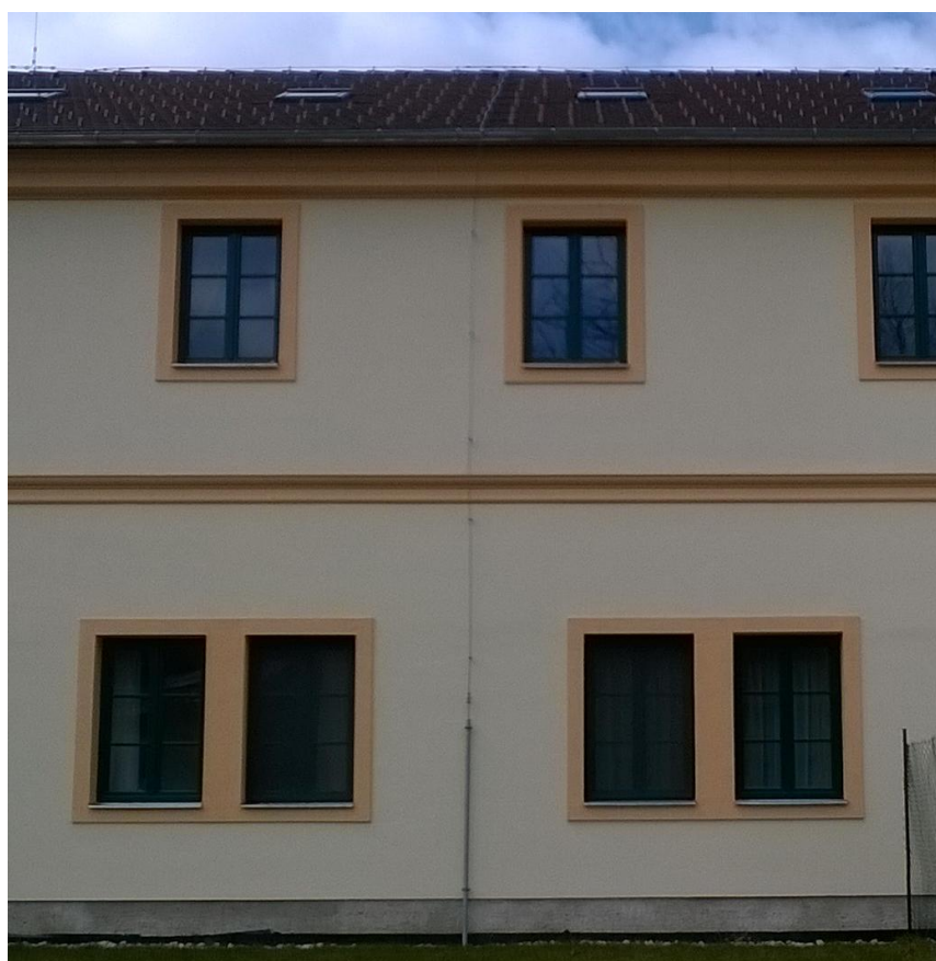
Obrázek 18 Pohled na jihovýchodní stěnu objektu
