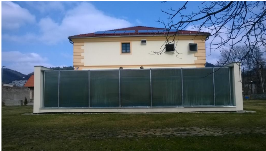
Obrázek 27 Solární kolektorové pole
