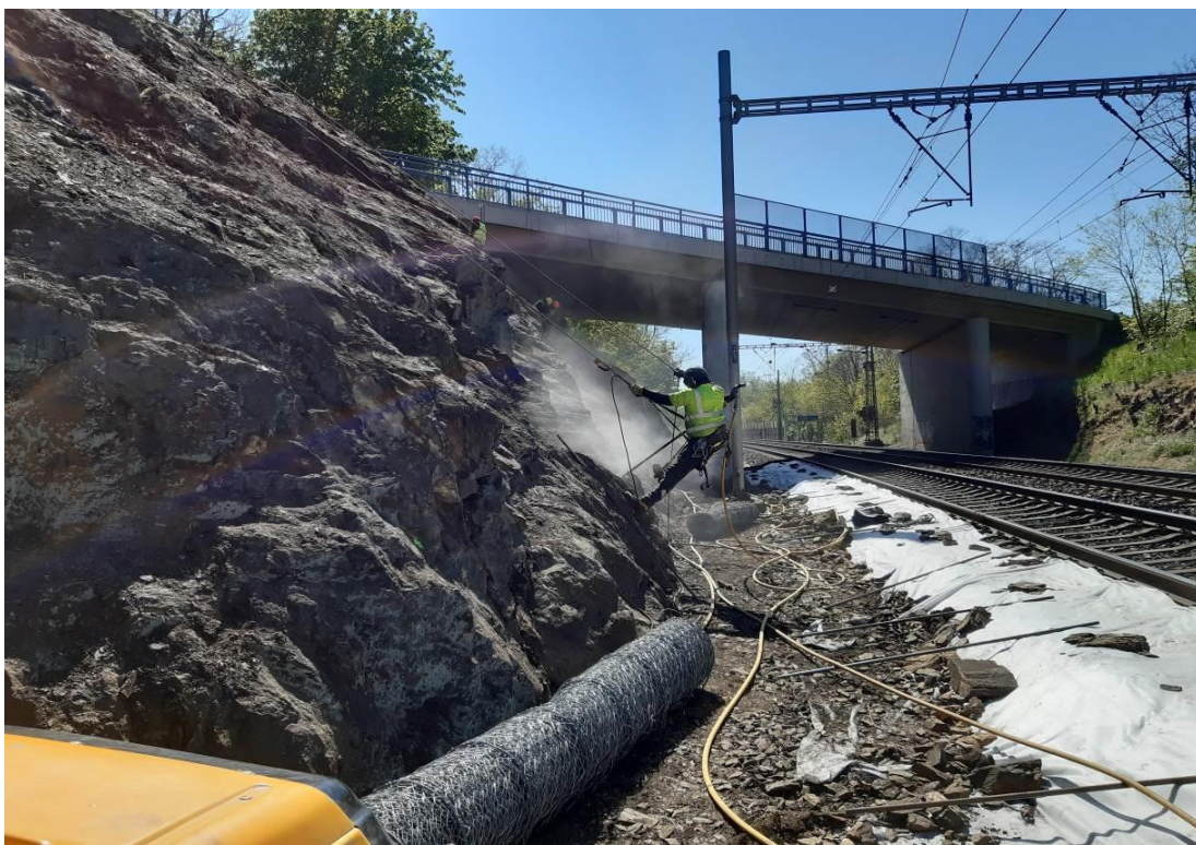
Obr.č.15: Zabezpečení skalního masivu Týnec nad Labem. (2018)
