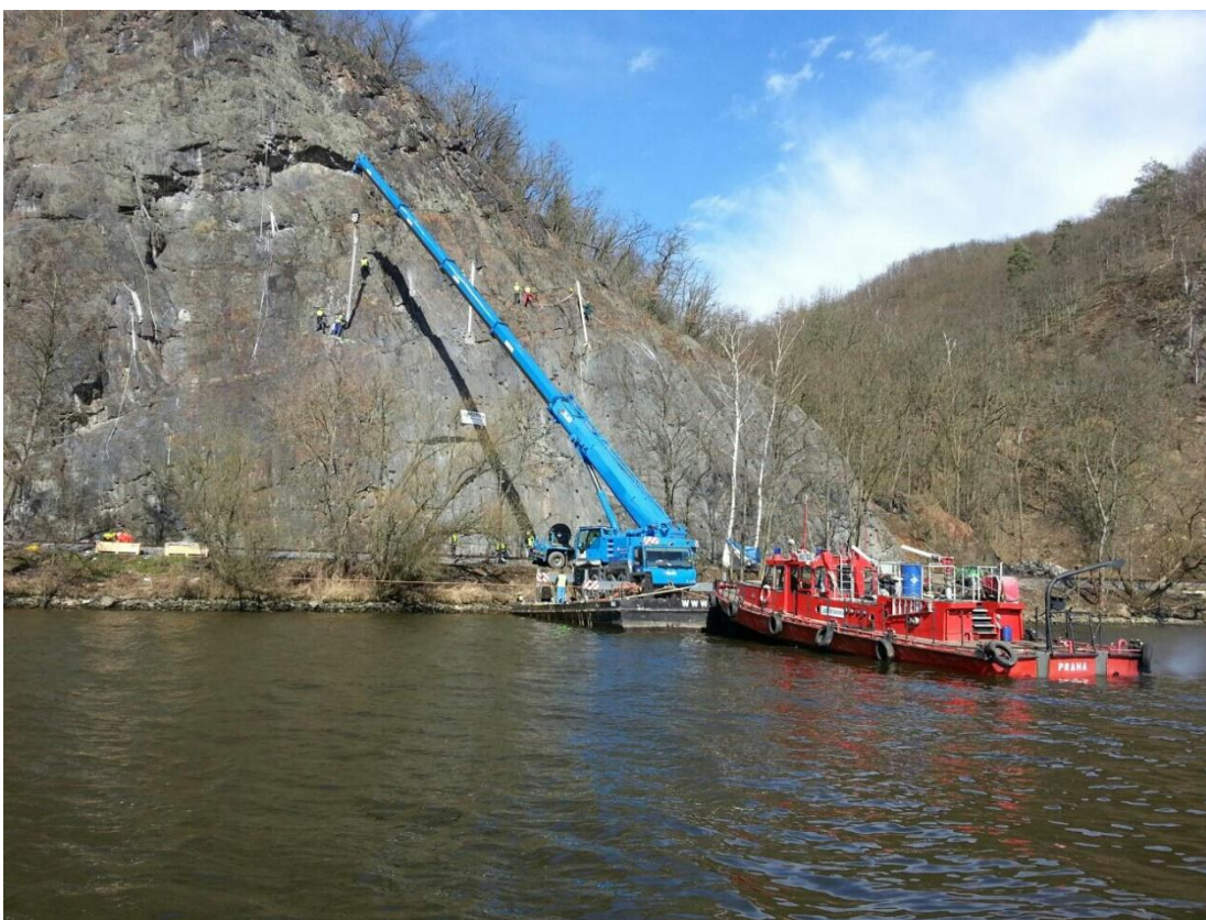
Obr.č.16: Instalace dynamické bariéry Skochovice. (2015)
