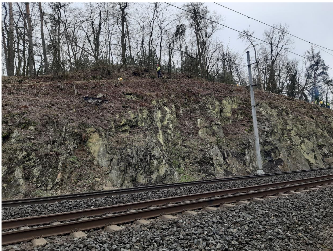
Obr.č.8: Nižkov, po realizaci údržby zeleně. (2018)
