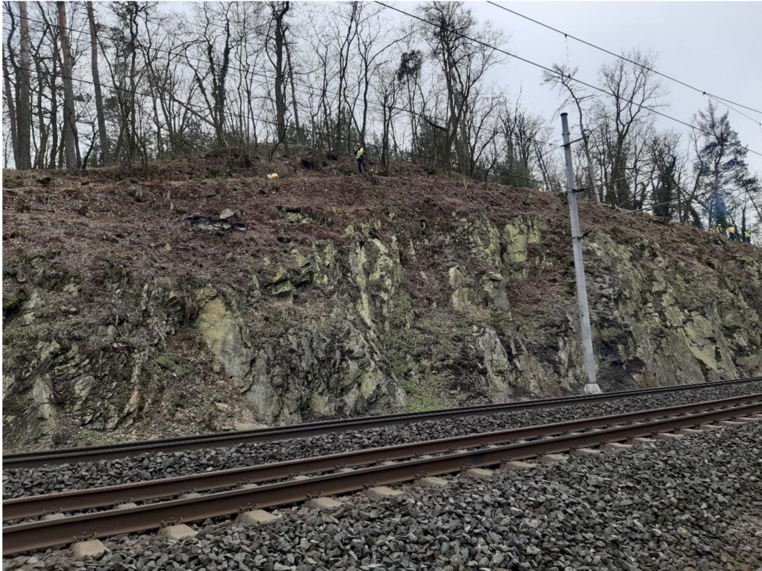
Obr.č.8: Nižkov, po realizaci údržby zeleně. (2018)
