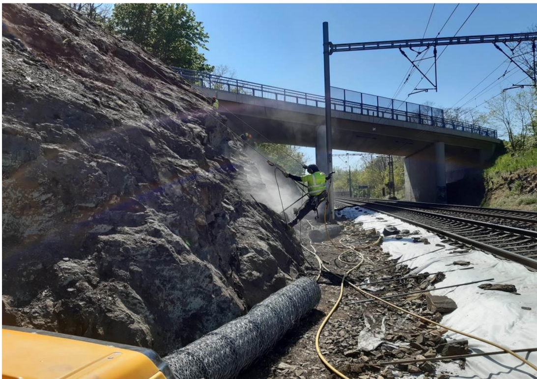
Obr.č.15: Zabezpečení skalního masivu Týnec nad Labem. (2018)
