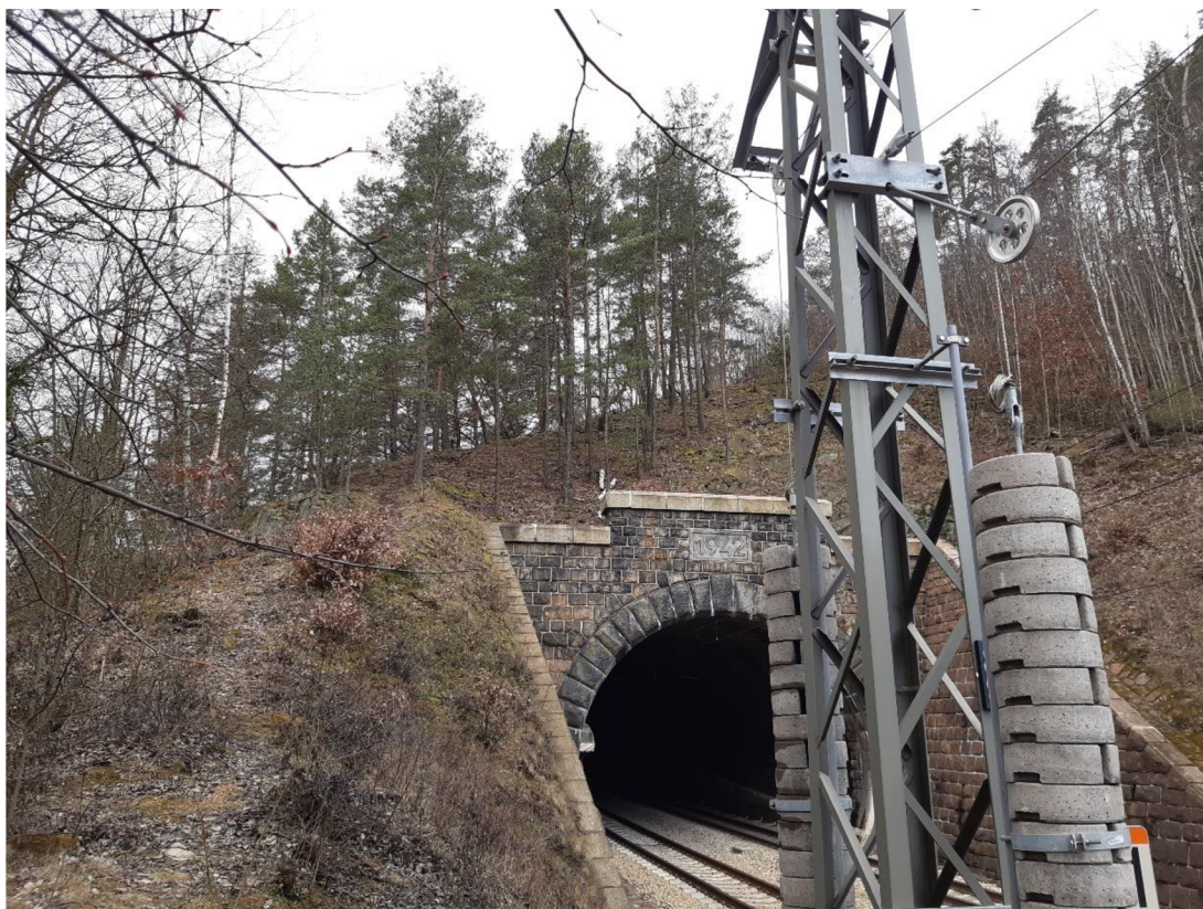
Obr.č.10: Stanice Strakonice před začátkem prací. (2018)
