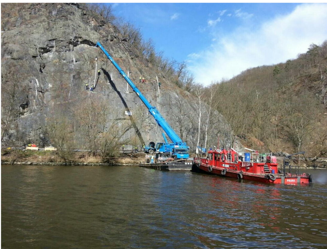
Obr.č.16: Instalace dynamické bariéry Skochovice. (2015)
