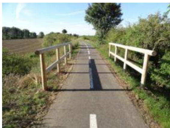
Obr. 60: Zábradlí nad propustkem (Nezamyslice).
