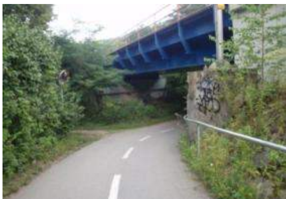
C-Obr. 41: Nevhodné směrové vedení komunikace pod mostem (Svitava).
