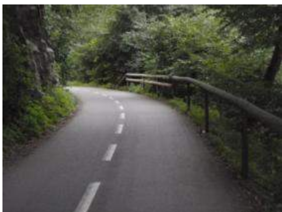
Obr. 59: Dřevěné zábradlí nad svahek (Bilovice nad Svitavou).
