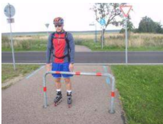
C-Obr. 46: Zábradlí využité jako záchytný prvek před křížením s motorovou dopravou v nevhodné výšce (Flaeming-Skate).
