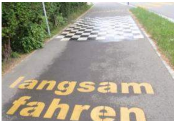
Obr. 55: Upozornění na snížení rychlosti pomocí zdrsnění povrchu nátěrem (Švýcarsko).
