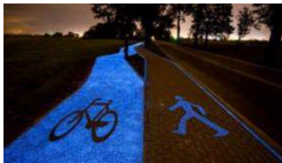
C-Obr. 53: Využití příměsí do asfaltového pojiva pro barevné rozlišení povrchu stezky.
