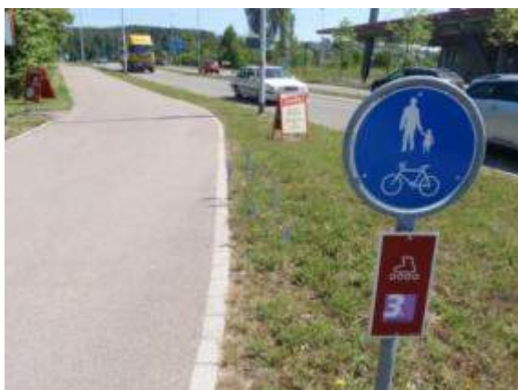
C-Obr. 4: Vedení in-line trasy po komunikaci se společným prostorem pro pěší a cyklisty (Švýcarsko).
