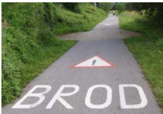
Obr. 51: Vodorovné značení upozorňující na křížení cesty vodou (Labská stezka).
