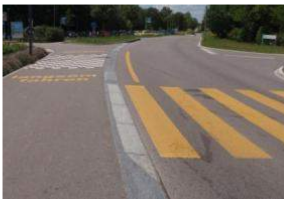
C-Obr. 22: Bezbariérové řešení snížení hrany přechodu využívaného bruslaři (Švýcarsko).
