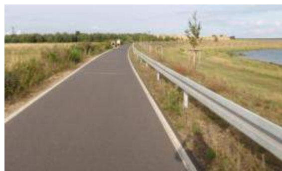
C-Obr. 51: Svodidlo jako bezpečnostní prvek při klopení v oblouku (Lužická jezera).
