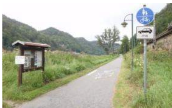
C-Obr. 7: Komunikace s odděleným (neodděleným) provozem chodců a cyklistů s možností vjezdu motorových vozidel (Labská stezka).
