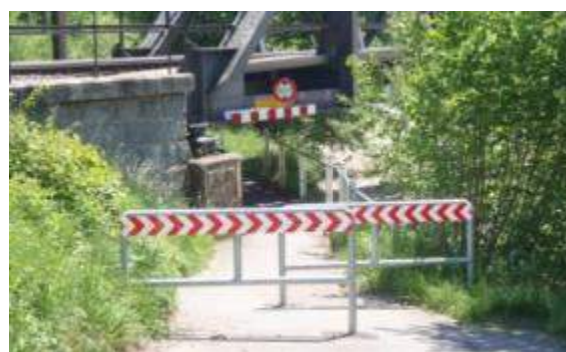
Obr. 58: Zábradlí upozorňující na zúžený a snížený průjezdný prostor pod mostem (Švýcarsko).
