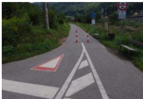
C-Obr. 49: Ukončení nemotorové komunikace s upozorněním na přednost jízdy (Labská stezka).
