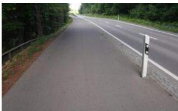
C-Obr. 27: Oddělení motorové a nemotorové dopravy pomocí zvýšeného pásu dlažby a vodících sloupků (Švýcarsko).
