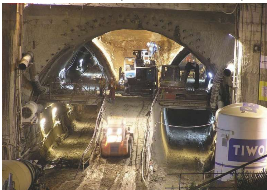
Obr. 2.1-2: Ražba samotných tunelů (snímek z roku 2009, zdroj: [6])
