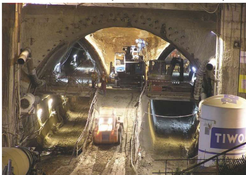
Obr. 2.1-2: Ražba samotných tunelů (snímek z roku 2009, zdroj: [6])
