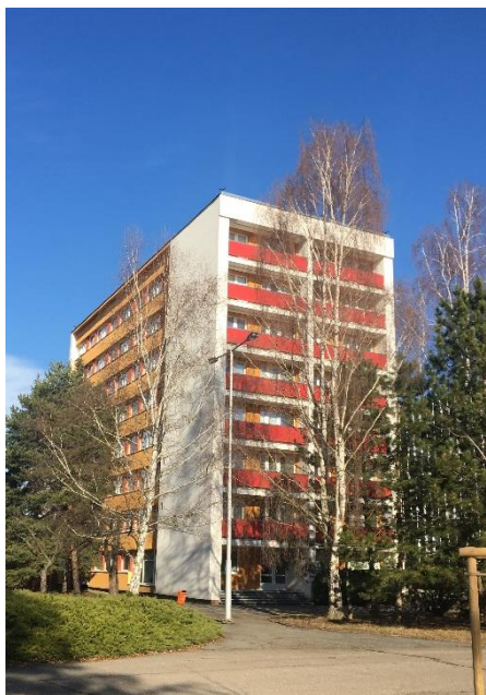
Obr. 4 - Budova domova mládeže, r. 2022 (foto autor)
