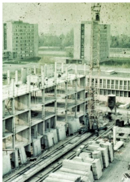
Obr. 3 - Výstavba budovy školy SUPŠ HNN, r. 1972 (foto archiv školy)
