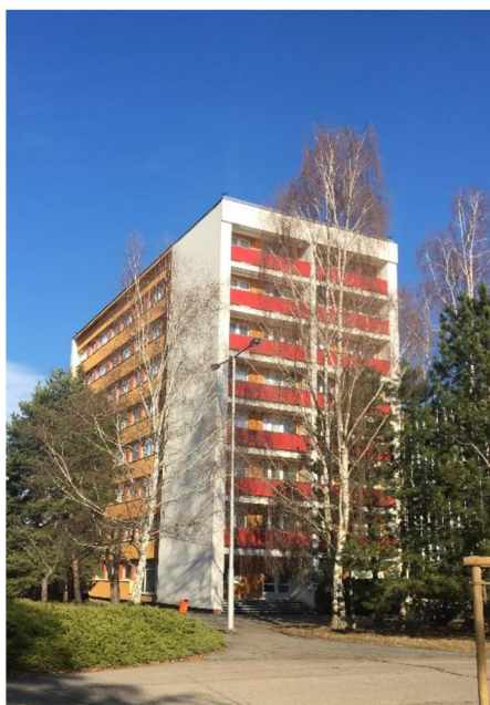
Obr. 4 - Budova domova mládeže, r. 2022 (foto autor)
