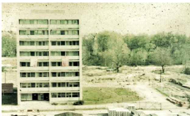
Obr. 2 - Budova domova mládeže, r. 1972 (foto archiv školy)
