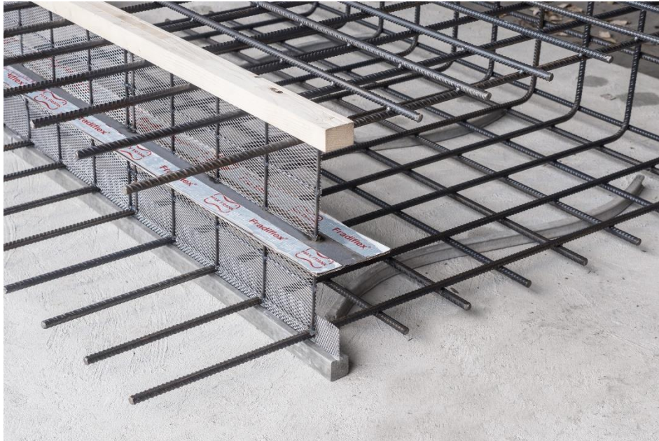
Obr. 4.3 – STREMAFORM – bednicí prvek s těsnícím plechem [28]
