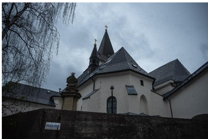
Karviná – Fryštát, kostel Povýšení sv. Kříže – pohled z jihovýchodu, 1. polovina 14. století, pozdější úpravy 1515–1530
