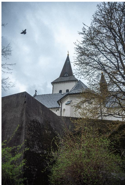
Karviná – Fryštát, kostel Povýšení sv. Kříže – pohled z jihu, 1. polovina 14. století, pozdější úpravy 1515–1530
