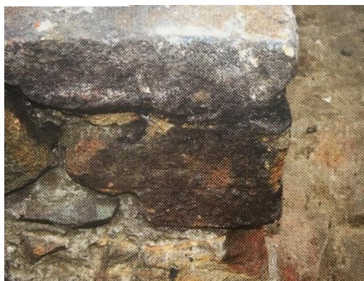
Karviná – Fryštát, kostel Povýšení sv. Kříže, nároží klasicistní sakristie, fragment klínového vyžlabeného žebra, 1. polovina 14. století.
