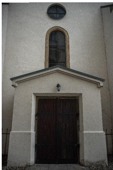
Karviná – Fryštát, kostel Povýšení sv. Kříže, předsíň do Moravské kaple, pohled ze severu, 1611–1617
