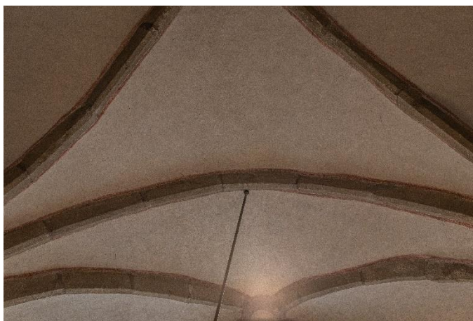
Karviná – Fryštát, kostel Povýšení sv. Kříže, severní kaple – detail žeber na rozhraní polí, 2. polovina 14. století
