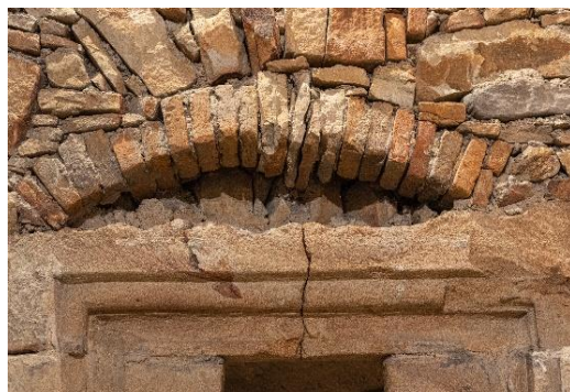
Karviná – Fryštát, kostel Povýšení sv. Kříže, portál z točitého schodiště do prvního patra věže – detail segmentového pasu, 1515–1530
