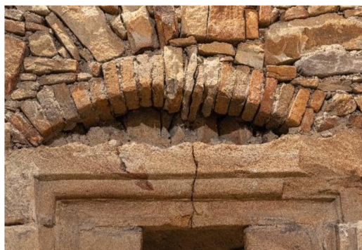
Karviná – Fryštát, kostel Povýšení sv. Kříže, portál z točitého schodiště do prvního patra věže – detail segmentového pasu, 1515–1530
