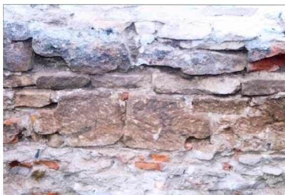
Karviná – Fryštát, kostel Povýšení sv. Kříže, základové obvodové zdivo klasicistní sakristie – dílce hruškových klenebních žeber, 2. polovina 15. století
