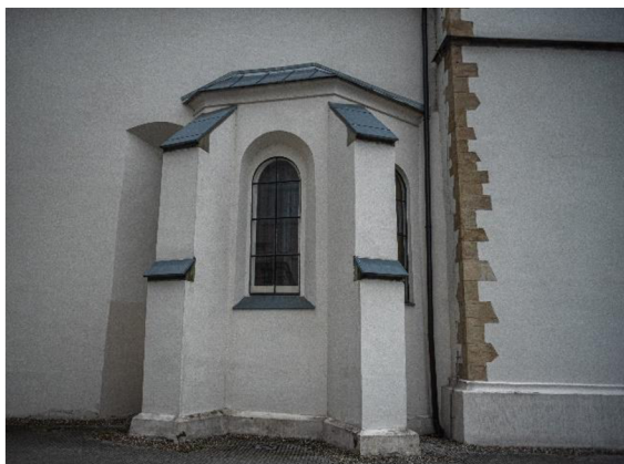
Karviná – Fryštát, kostel Povýšení sv. Kříže, severní kaple, pohled ze severu, 2. polovina 14. století
