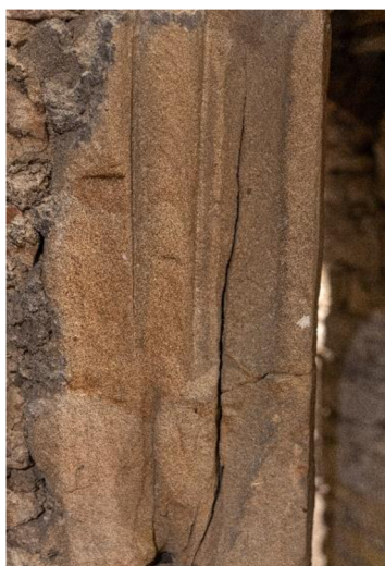
Karviná – Fryštát, kostel Povýšení sv. Kříže, portál z točitého schodiště do prvního patra věže – detail prutů, 1515–1530
