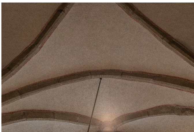
Karviná – Fryštát, kostel Povýšení sv. Kříže, severní kaple – detail žeber na rozhraní polí, 2. polovina 14. století
