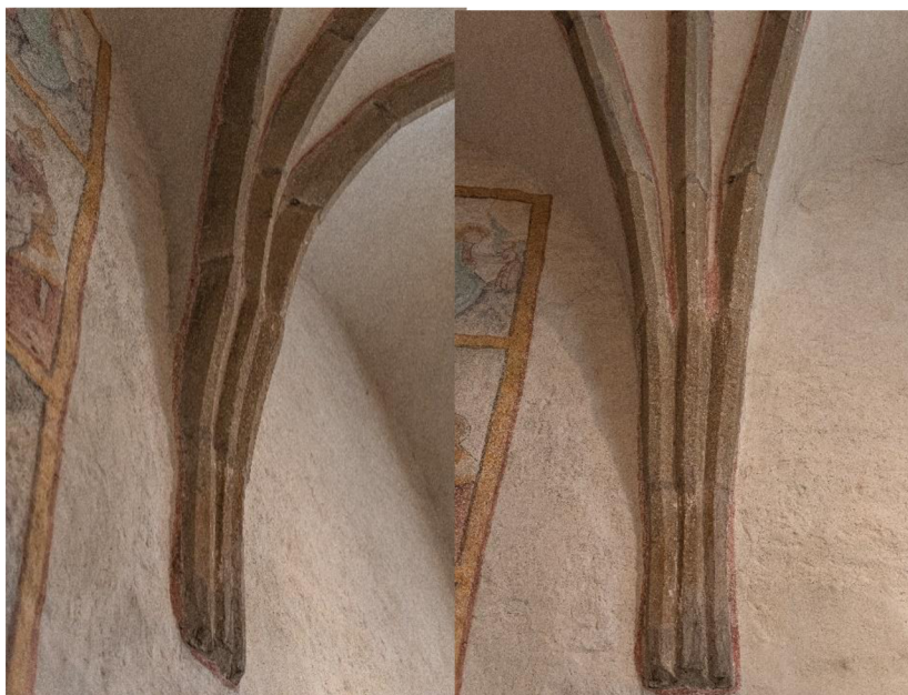
Karviná – Fryštát, kostel Povýšení sv. Kříže, severní kaple – detail žeber na rozhraní polí, 2. polovina 14. století
