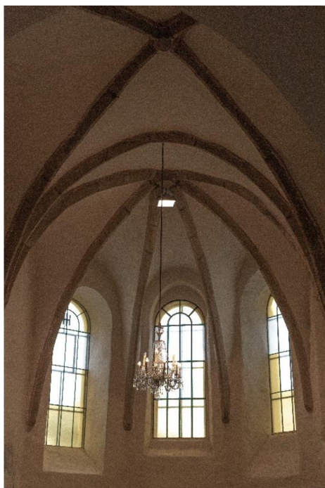
Karviná – Fryštát, kostel Povýšení sv. Kříže, severní kaple – detail klenby, 2. polovina 14. století
