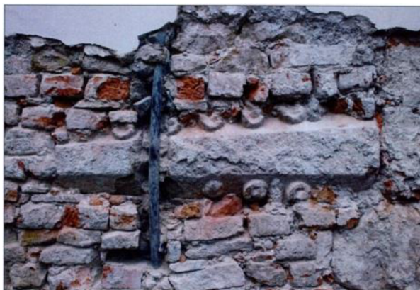
Karviná – Fryštát, kostel Povýšení sv. Kříže, nadzemní obvodové zdivo klasicistní sakristie – fragment gotické fiály, 2. polovina 15. století
