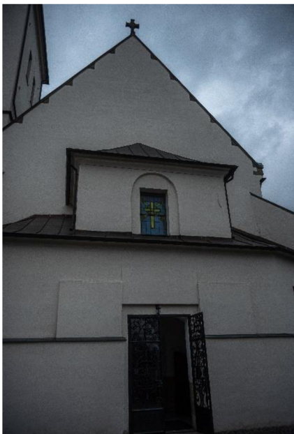
Karviná – Fryštát, kostel Povýšení sv. Kříže, západní průčelí, 1515–1530, 1. čtvrtina 19. století
