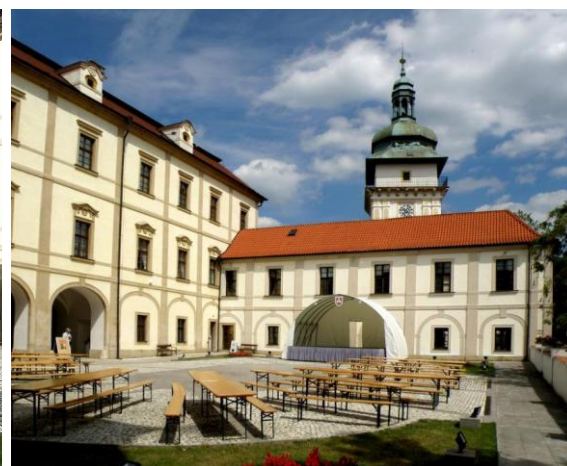
Obrázek 17 – Severní a východní křídlo z nádvoří ( http://pamatky.benatky.cz/zamecka-budova )
