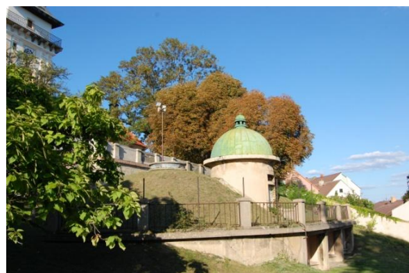
Obrázek 42 – Zemní vodojem, pohled z boku (M. Souček – soukromý archiv)
