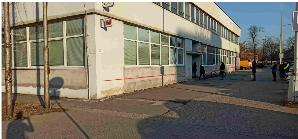
Obr. 6.57: Vhodné miesto na fasáde budovy pošty [zdroj: vlastný].
