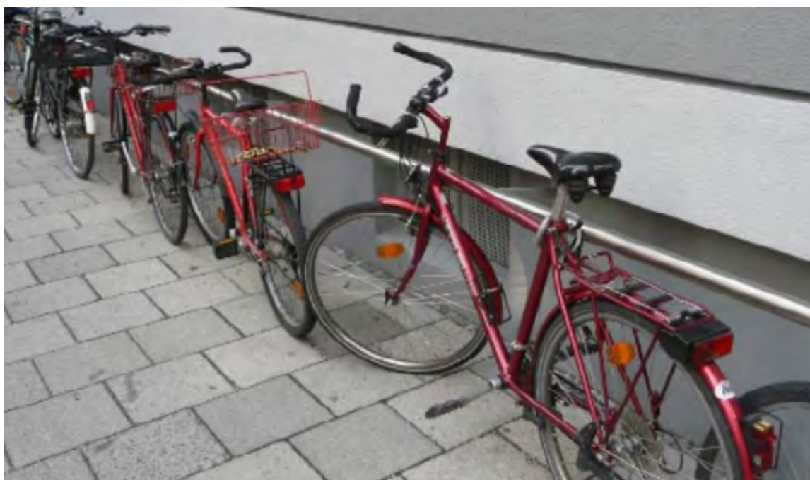
Obr. 6.26: Príklad vhodného stojanu kotveného do steny budovy. Obrázok je prevzatý z [6].
