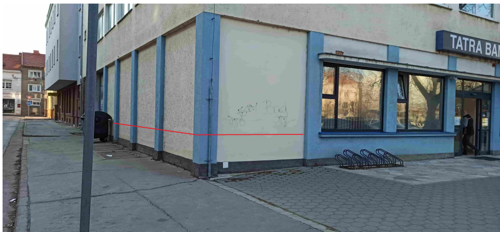
Obr. 6.38: Roh budovy banky [zdroj: vlastný].
