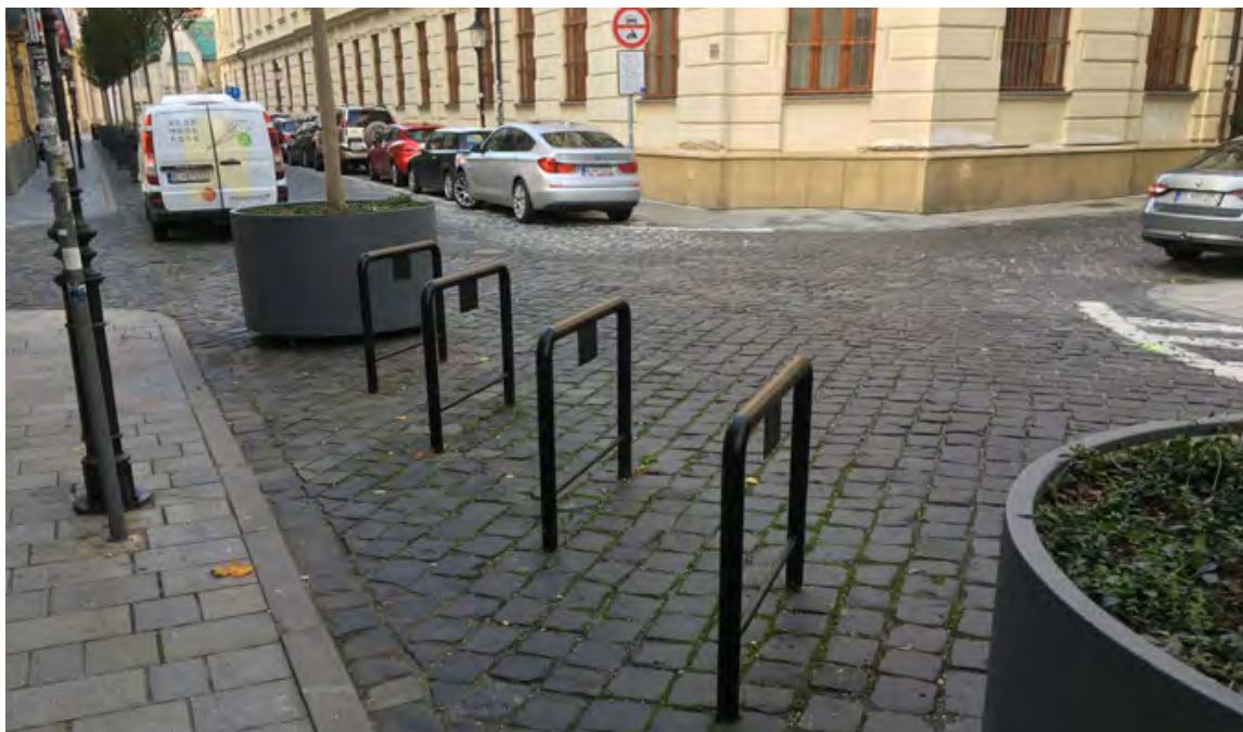
Obr. 6.25: Príklad vhodného stojanu kotveného podpovrchovo. Obrázok je prevzatý z [6].
