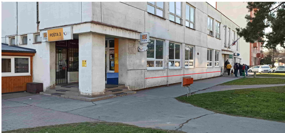
Obr. 6.50: Vhodné miesto na fasáde budovy pošty [zdroj: vlastný].
