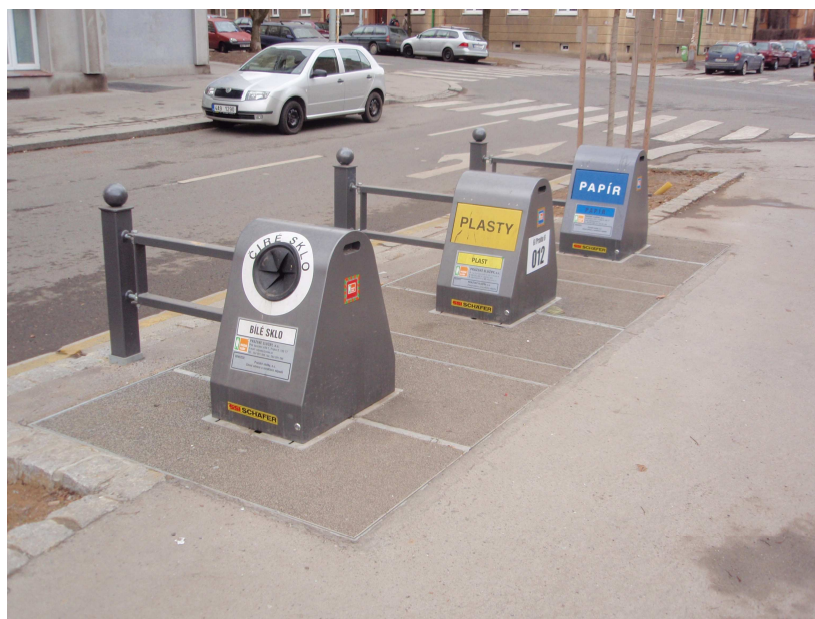
Obr. 10 Kontejnery na sklo, plast a papír uložené v zemi
