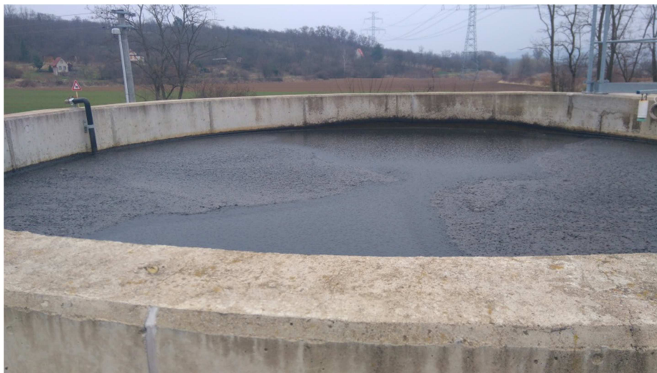
Obr. 7.1 Otevřená vyhřívací nádrž ČOV Ledce
