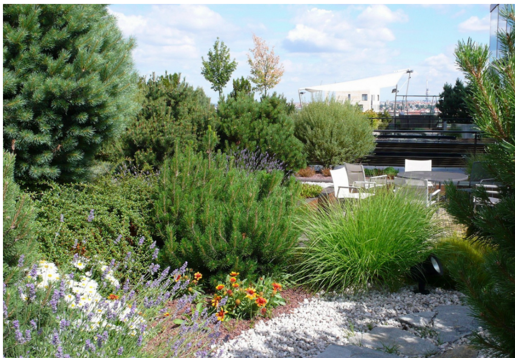
Obr. 5 – Střešní terasa administrativní budovy DELTA v Praze 4. Pobytová intenzivní zelená střecha slouží jako odpočinkové místo pro zaměstnance a také se zde konají firemní akce. Zdroj: SZÚZ 2018
