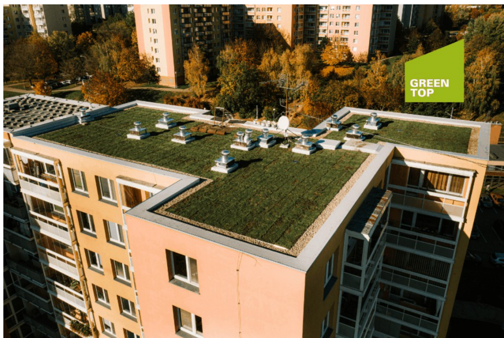
Obr. 10 – Extenzivní zelená střecha na panelovém bytovém domě v Brně-Bohunicích. Pomáhá vyrovnávat extrémní teploty, a to zejména v bytech pod střechou. Zdroj: SZÚZ 2022
