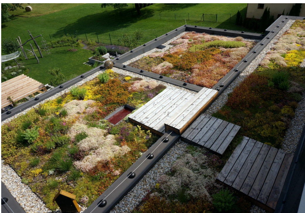
Obr. 8 – Pobytová extenzivní zelená střecha na novostavbě rodinného domu v Horních Bludovicích. Střecha se nachází v prvním patře domu a lze ji vidět z většiny místností. Vegetaci doplňuje malá dřevěná terasa, posedové schody a decentní vodní prvek. Zdroj: SZÚZ 2022
