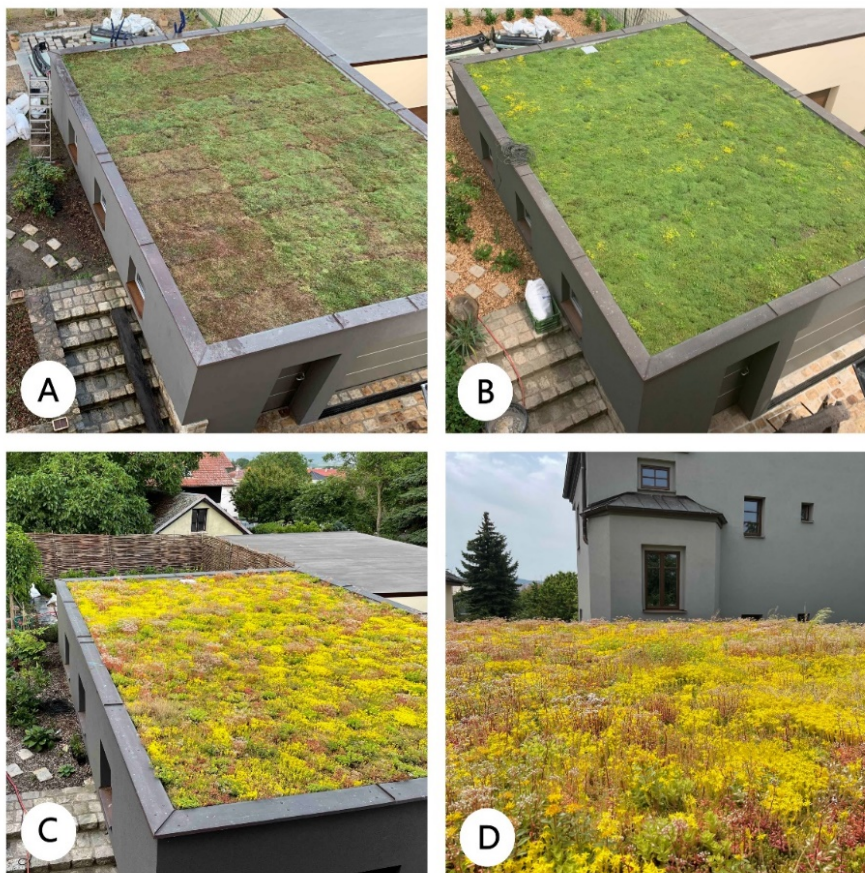
Obr. 11 – Rozchodníková střecha na garáži, vlastní realizace.
