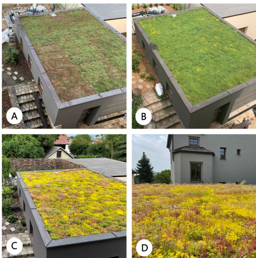
Obr. 11 – Rozchodníková střecha na garáži, vlastní realizace.
