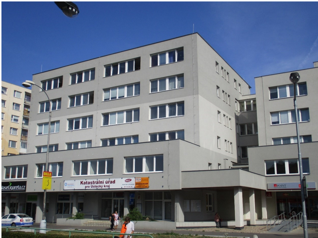
Obr. 1 Budova katastrálního pracoviště Chomutov
