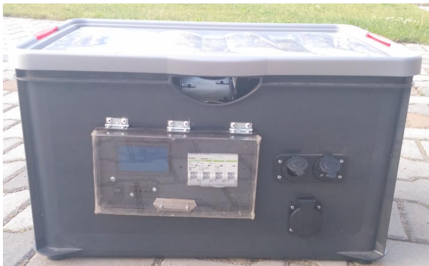
Obrázek 66. Finální usazení elektrárny 1
