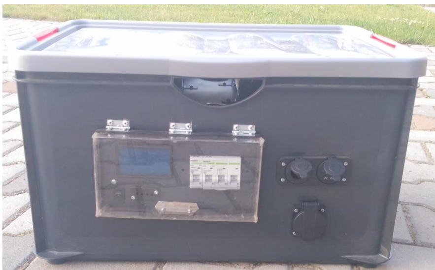
Obrázek 66. Finální usazení elektrárny 1
