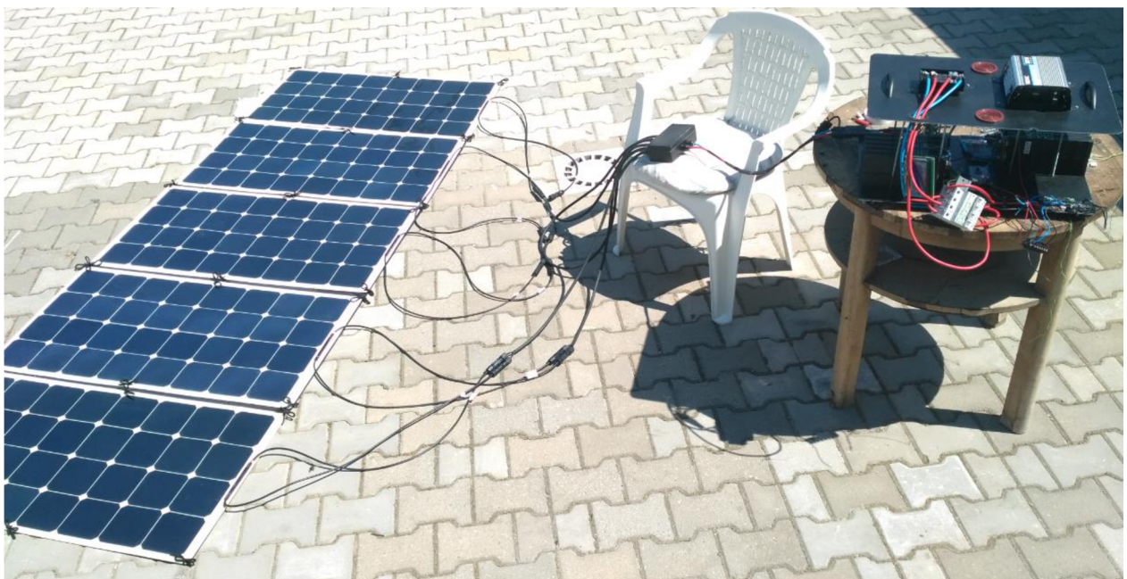
Obrázek 65. Elektrárna během testování své funkčnosti před finálním usazením do přepravního boxu
