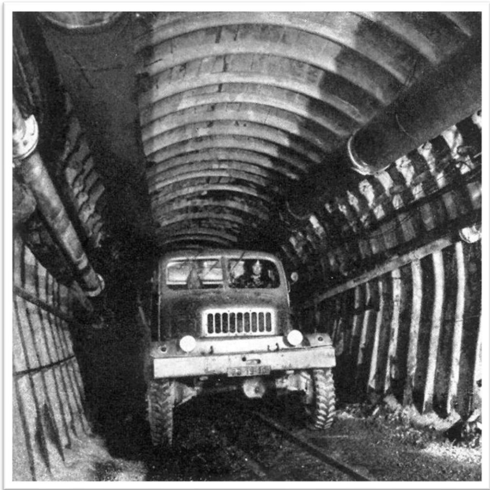
Obrázek 11: Štolový přivaděč: Těžení rubaniny (Chlum, 1974).
