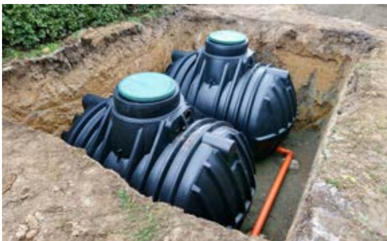
(obr. 17 - podzemní jímka vody)
