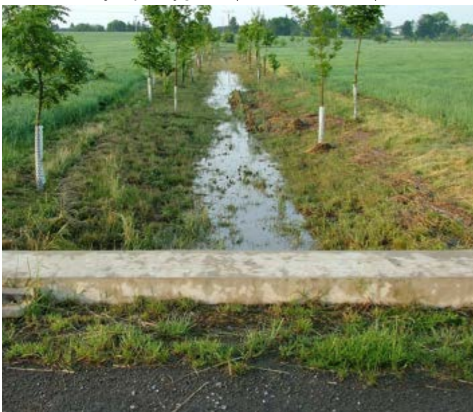
(obr. 18 - vsakovací průleh)
