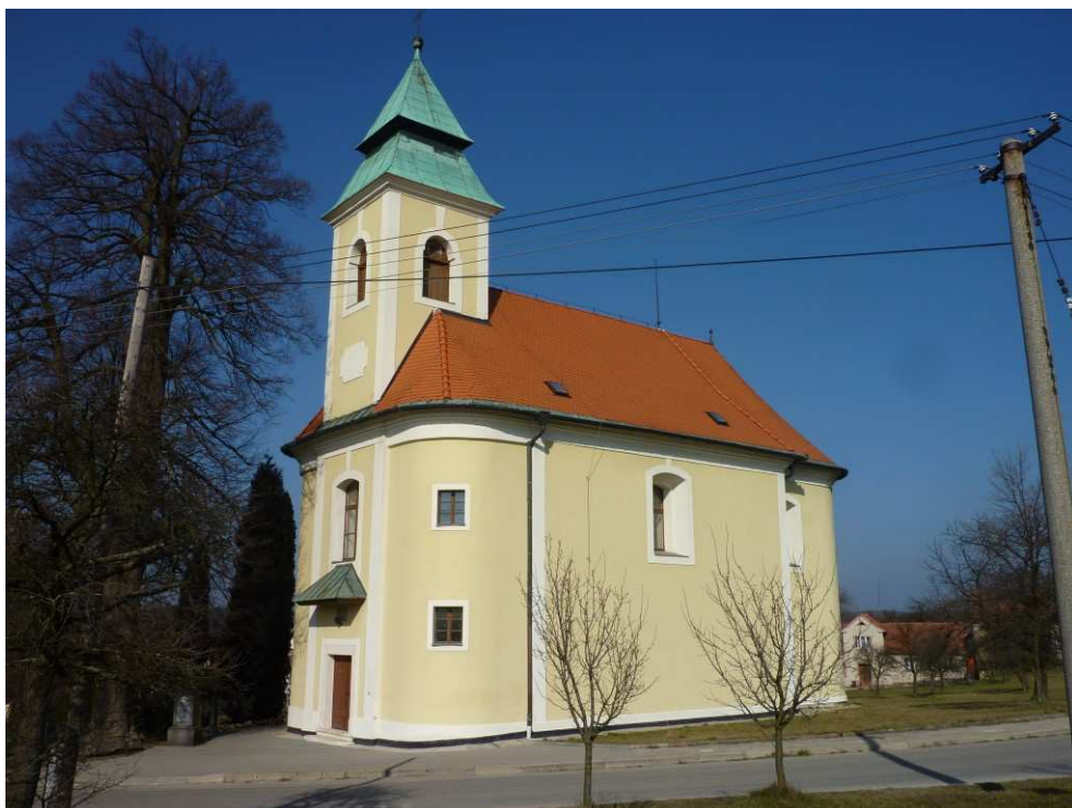
Filiální kostel Nanebevzetí Panny Marie v Bukovince, okr. Blansko (stav v roce 2014)
