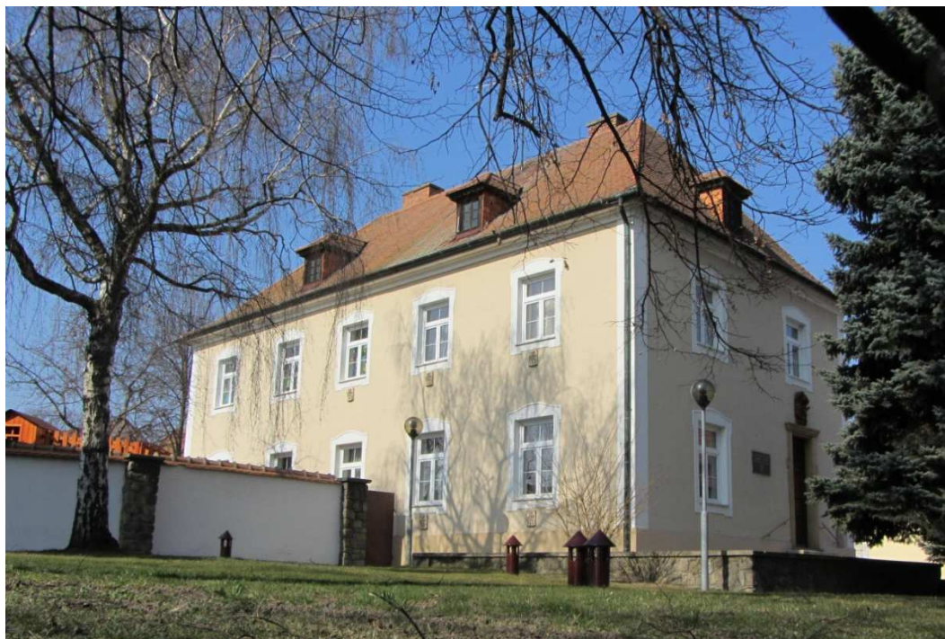
Budova římskokatolické fary v Dolních Bojanovicích (stav v roce 2014)
