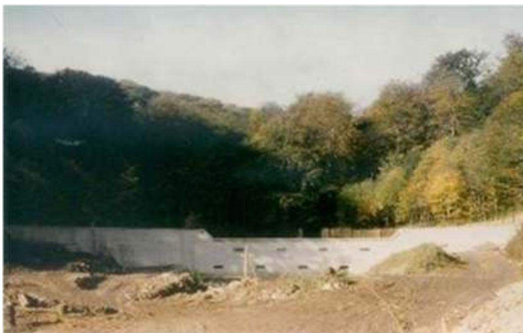
Obrázek č. 16.- Lužecký potok- štěrková přehrážka po dokončení výstavby (Pondělíček, 2018)
