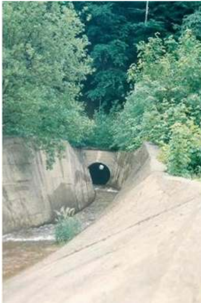
Obrázek č. 13.- štola Albrechtice průhled od vtoku do štoly (Pondělíček, 1982)
