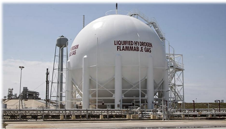
Obr. 33 – Skladování kapalného vodíku v Dewarových nádobách [103]
