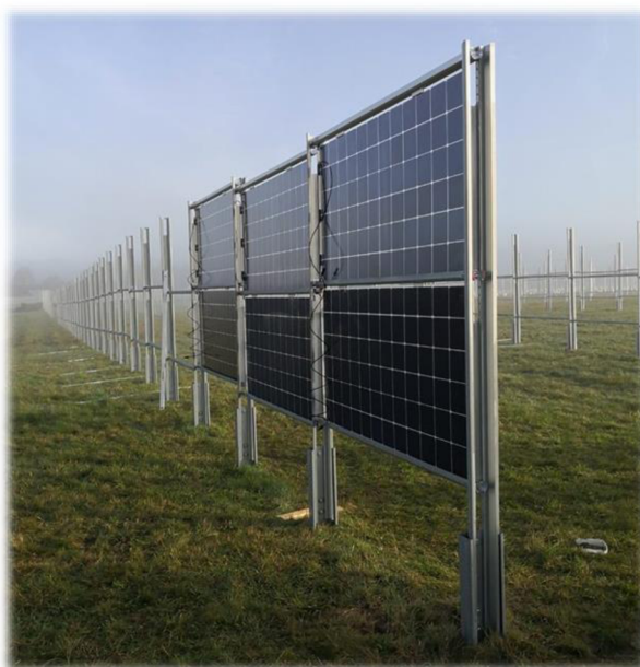
Obr. 8 – Fotovoltaické panely AgriPV od společnosti Next2Sun [13]
