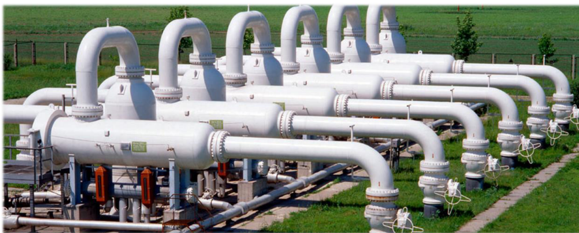
Obr. 51 – Dvoustupňové filtry plynu užívané při vtláčení vodíku do ZP [182]
