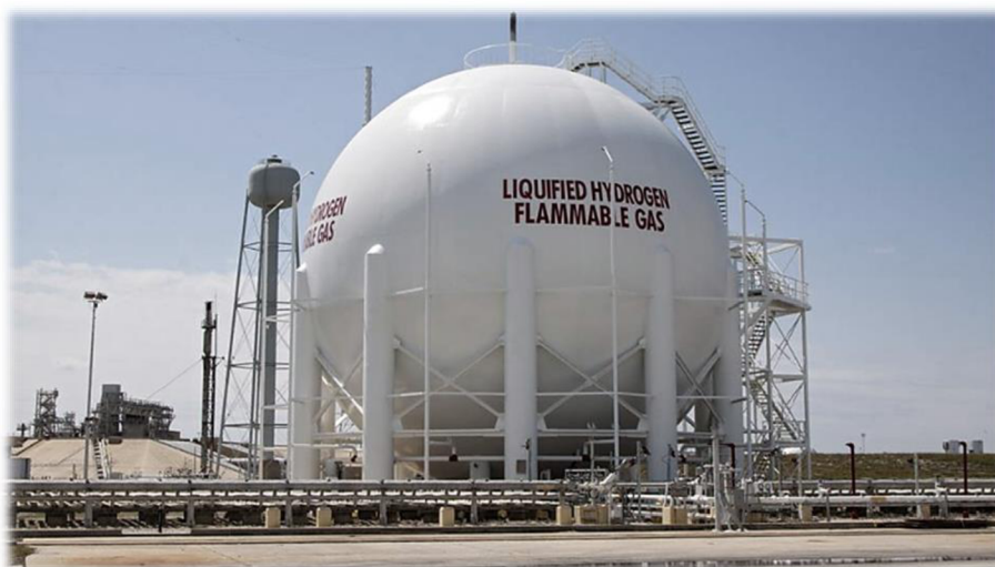
Obr. 33 – Skladování kapalného vodíku v Dewarových nádobách [103]
