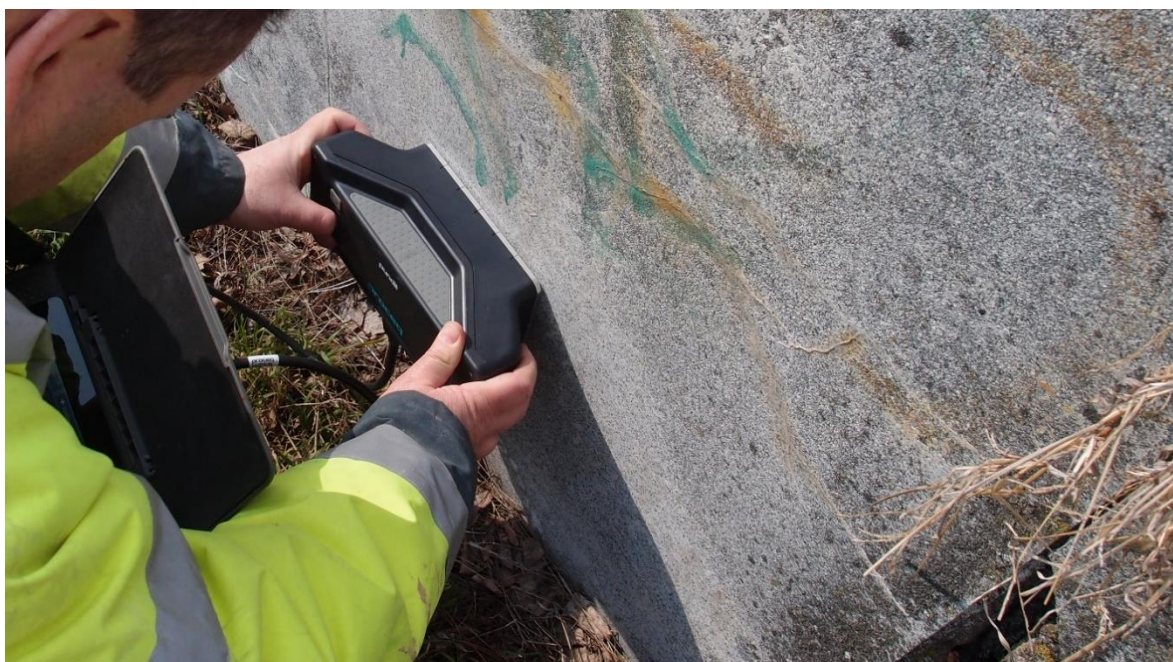
Obr. 3 Echo metoda prozvučování konstrukce.
