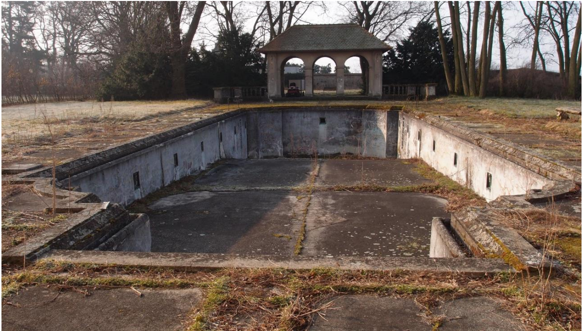
Obr. 10 Celkový pohled na bazén.
