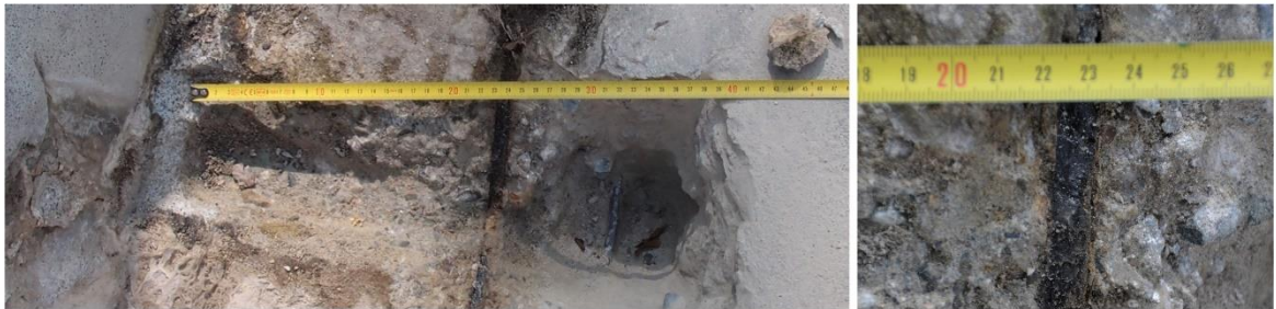
Obr. 39 Sekaná sonda dna – celkový pohled a detail.
