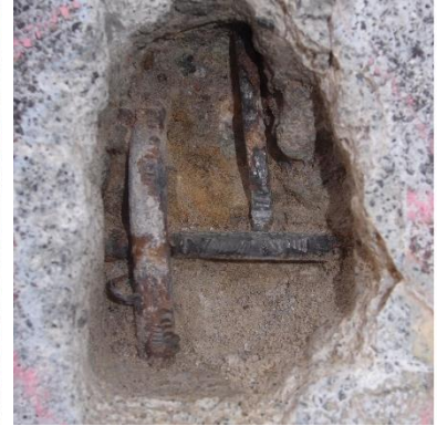
Obr. 33 Sekaná sonda V3C
