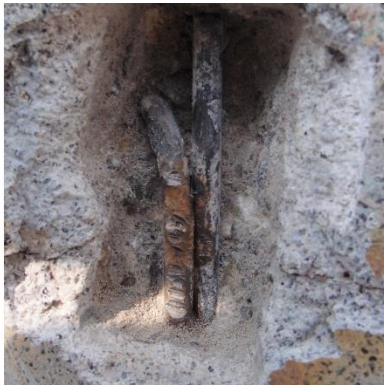
Obr. 35 Sekaná sonda V1A.
