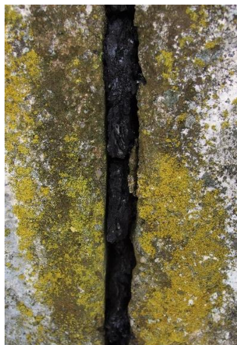
Obr. 16 Stav dilatační spáry – detail.
