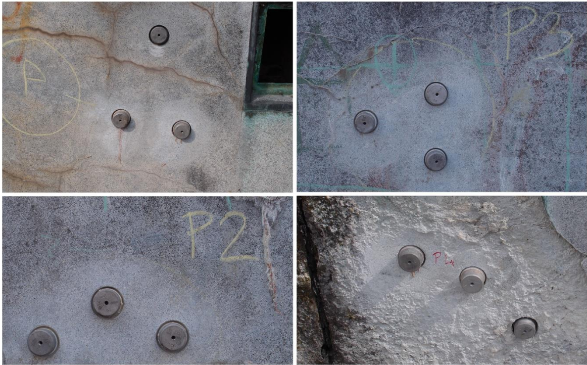
Obr. 49 Přehled zkušebních míst P1 – P4.
