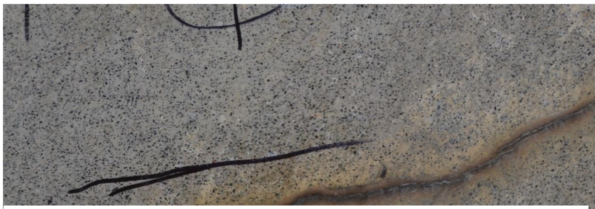
Obr. 13 Povrchová vrstva – vyleštěné světlé teraco.
