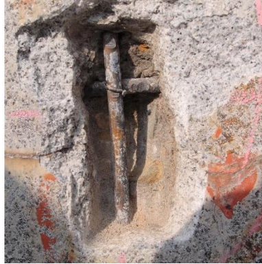
Obr. 34 Sekaná sonda V1B
