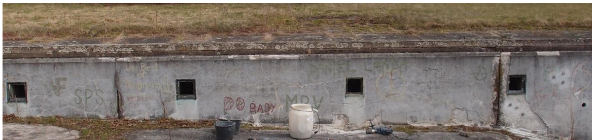
Obr. 11 Pohled na osvětlovací šachtice a svislé dilatační spáry.
