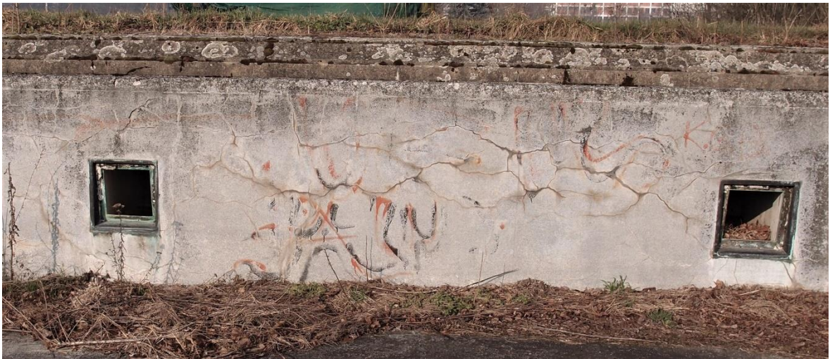
Obr. 21 Celkový pohled na vnější stav osvětlovacích šachtic.
