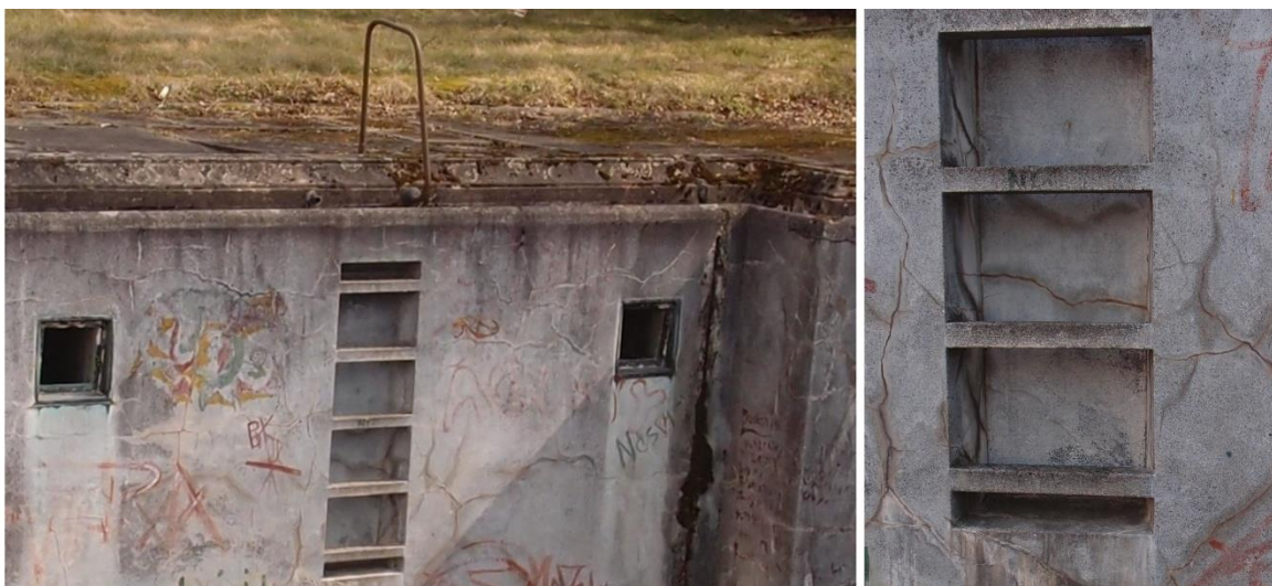
Obr. 12 Zapuštěný žebřík – pohled na celek a detail.
