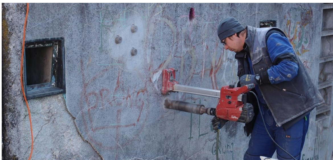
Obr. 5 Jádrové vrtání – stojanový vrtací systém Hilti DD120.
